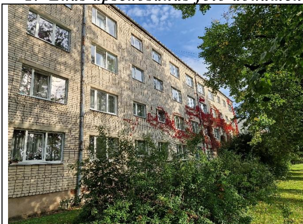
1.att. Ēkas D fasāde
