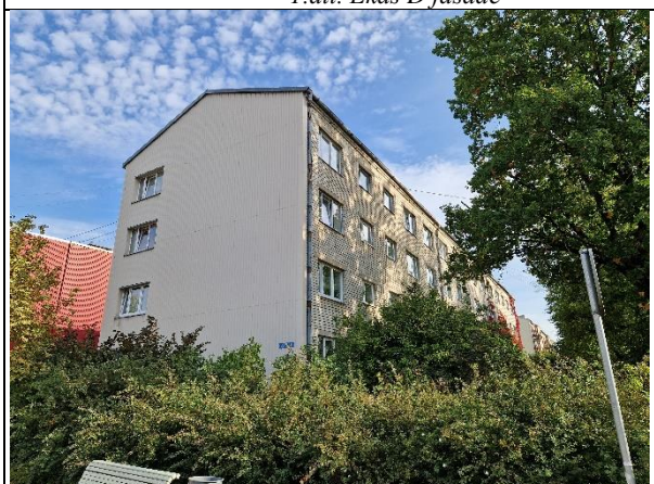
3.att. Ēkas RD un AZ fasādes ir siltinātas
