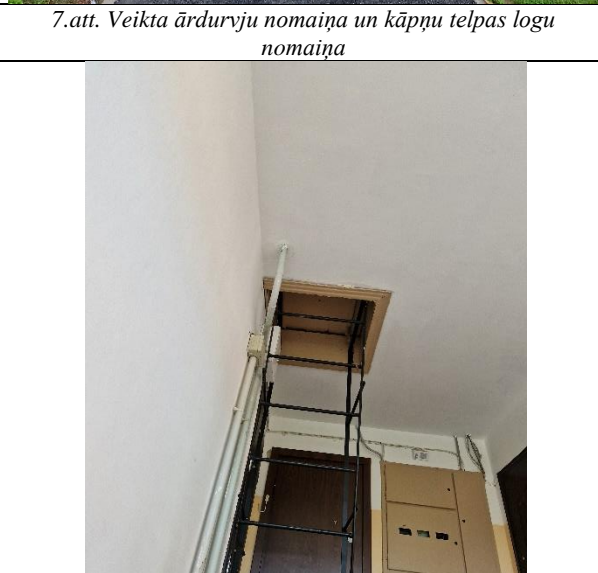
9.att. Nepieciešams veikt jumta lūku nomaini, kā arī nepieciešams nodrošināt, lai bēniņu telpā nevarētu iekļūt putni
