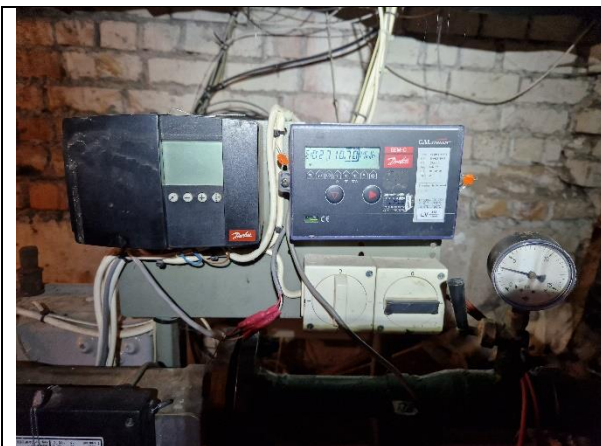
5. Ēkā uzstādīts neatkarīgā pieslēguma tipa siltummezgli, kurā tiek padots ēkas apkures loka siltumnesējs, kā arī tiek sagatavots karstais ūdens.
