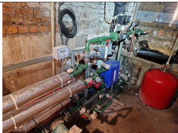
5. Ēkā uzstādīts neatkarīgā pieslēguma tipa siltummezgli, kurā tiek padots ēkas apkures loka siltumnesējs, kā arī tiek sagatavots karstais ūdens.
