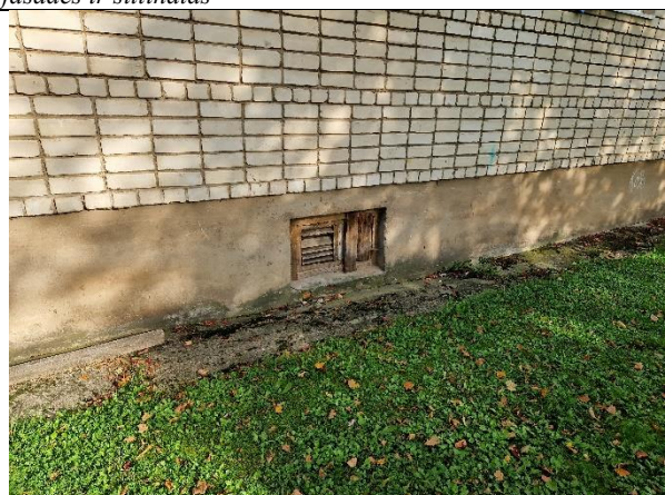
4.att. Nepieciešams veikt pamatu apmales atjaunošanu, lai nodrošinātu efektīvu lietussūdens novadīšanas sistēmas darbību un nepieļautu ūdens uzkrāšanos un mitruma iesūkšanos pamatos
