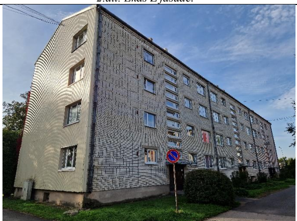
3.att. Ēkas RD un AZ fasādes ir siltinātas
