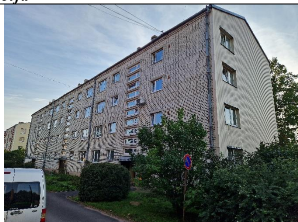
2.att. Ēkas Z fasāde.
