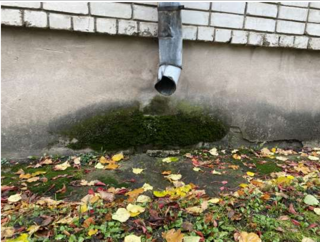
4.1.4. att. Ēkas pamatu apmales
