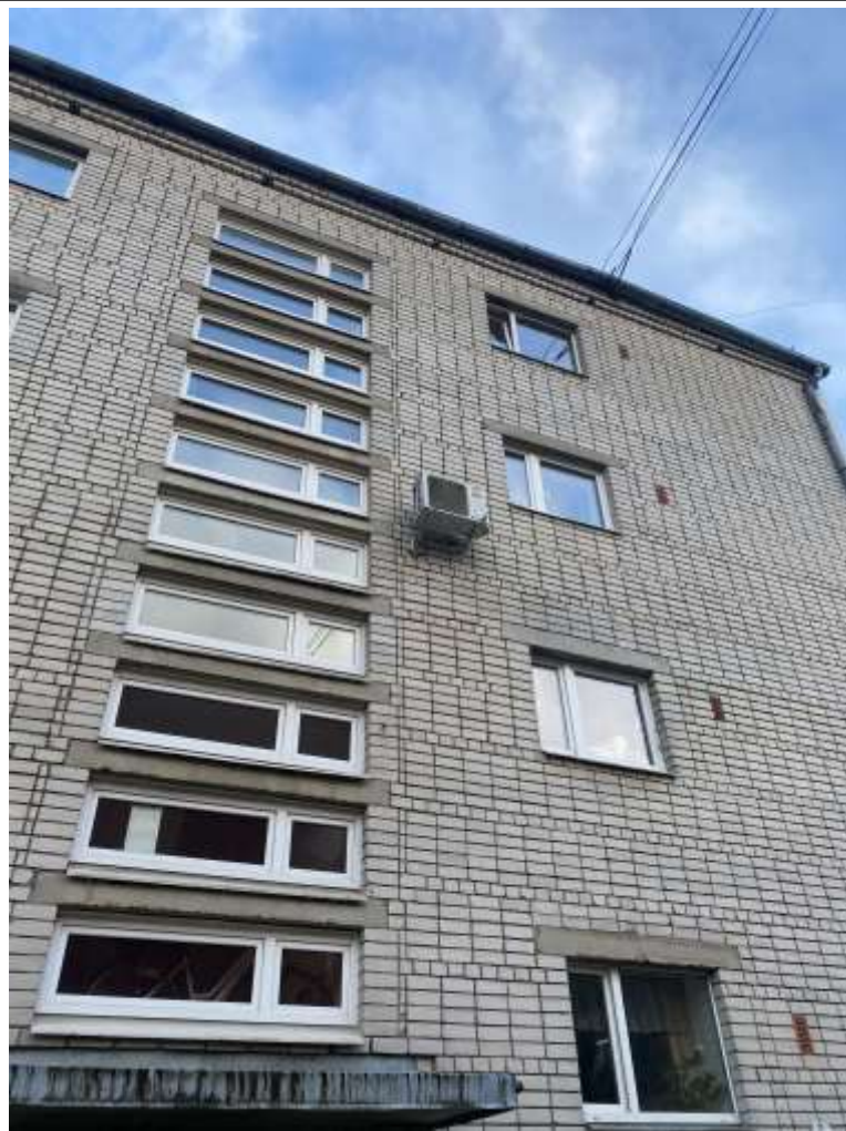
4.2.2.att. Silikātķieģeļu nesošās ārsienas
