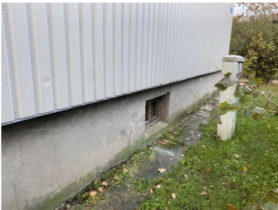
4.1.4. att. Ēkas pamatu apmales
