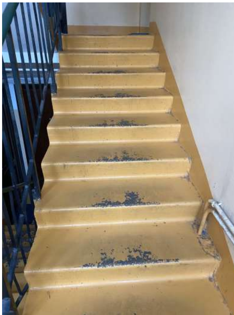
4.10.1.att. Dzelzsbetona konstrukciju starpstāvu kāpnes
