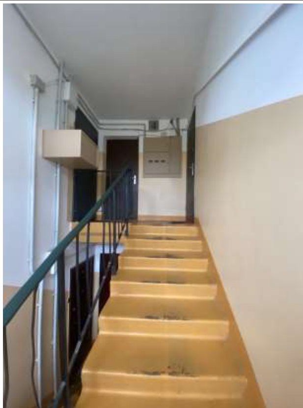
4.10.2.att. Dzelzsbetona konstrukciju kāpnes
