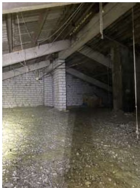
4.8.1.att. Jumta konstrukcijas
