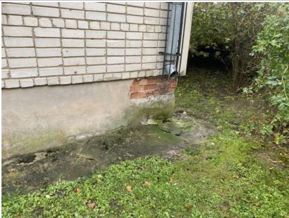
4.1.3. att. Ēkas pamatu apmales
