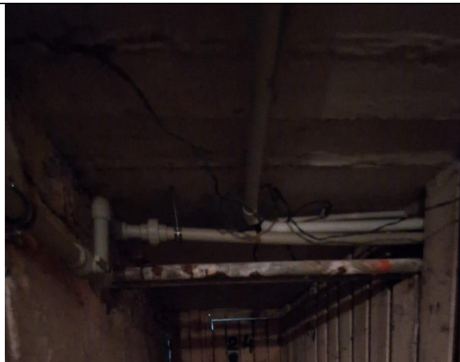
5.1.2. att. Ūdens apgādes cauruļvadi
