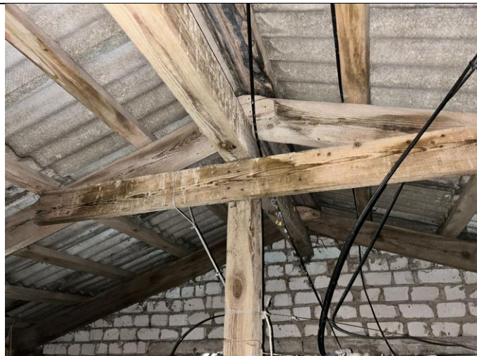
4.8.2. att. Jumta konstrukcijas
