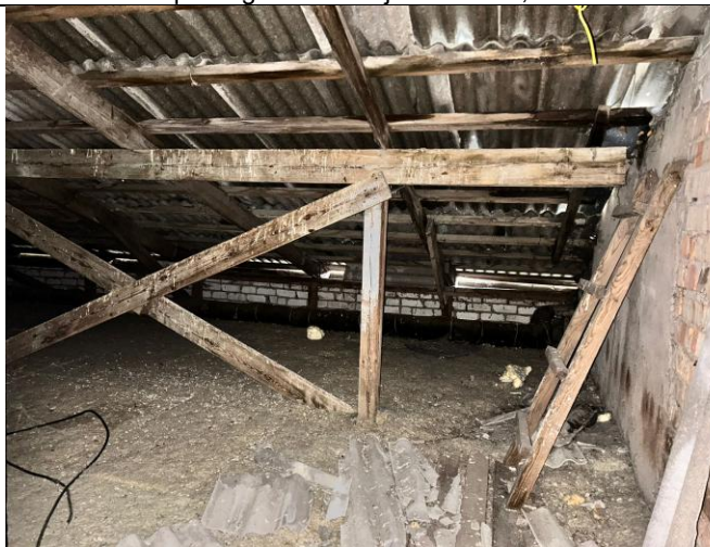
4.8.1. att. Jumta konstrukcijas
