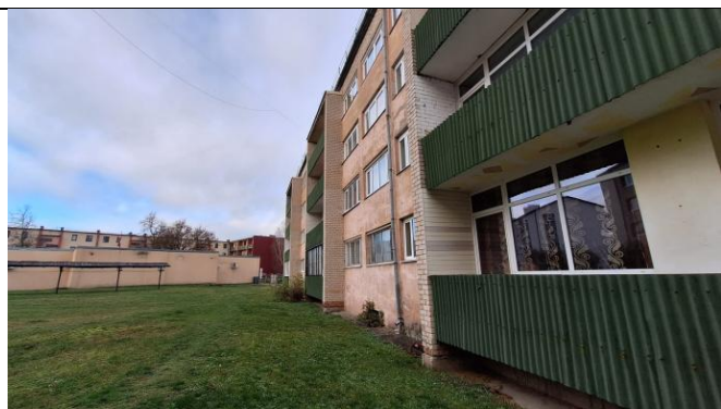
4.9.2. att. Lodžiju konstrukcijas
