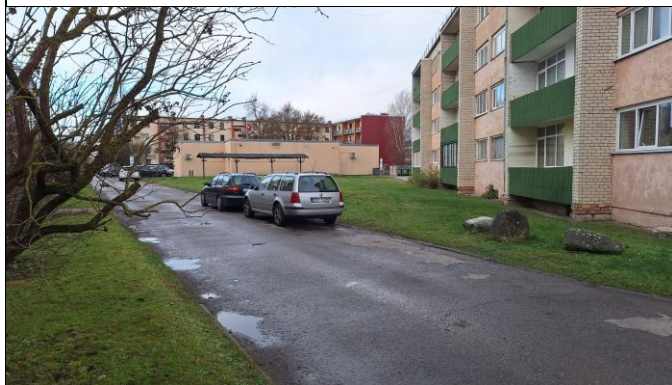
3.1.3. att. Ceļš gar ēkas dienvidu puses fasādi
