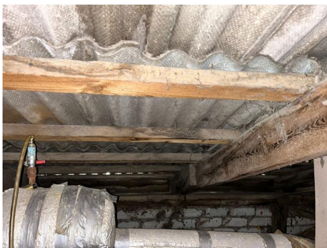
4.8.5. att. Jumta konstrukcijas
