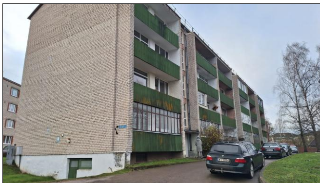
4.9.1. att. Lodžiju konstrukcijas
