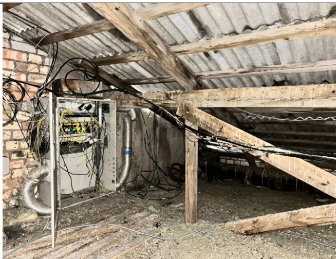
4.8.3. att. Jumta konstrukcijas
