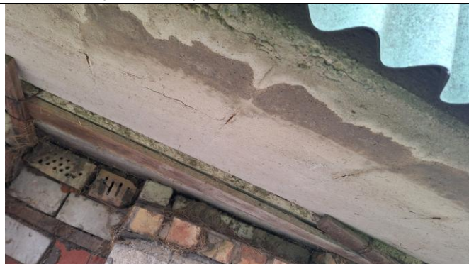
4.9.4. att. Lodžiju konstrukcijas
