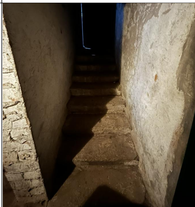
4.10.6. att. Pagraba kāpņu konstrukcija
