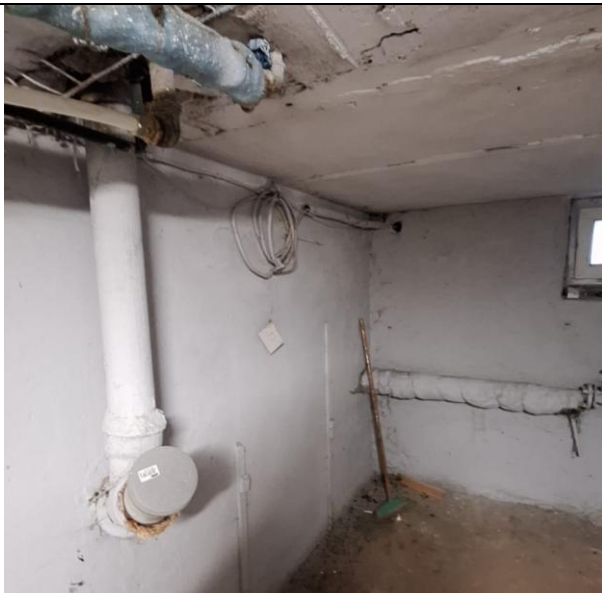
5.1.3. att. Daļēji nomainīti kanalizācijas sistēmas cauruļvadi
