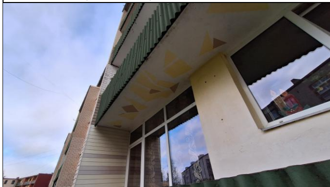
4.9.3. att. Lodžiju konstrukcijas
