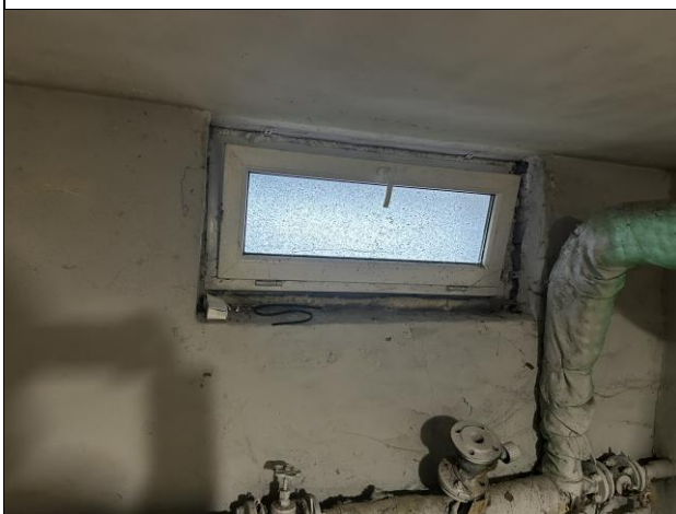
4.13.5. att. Pagraba PVC konstrukcijas logi
