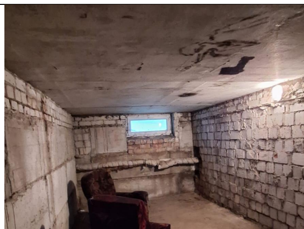
4.13.6. att. Pagraba PVC konstrukcijas logi
