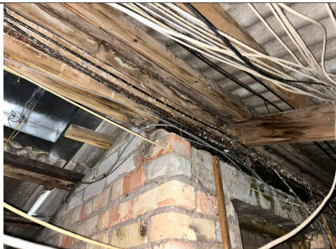
4.8.4. att. Jumta konstrukcijas
