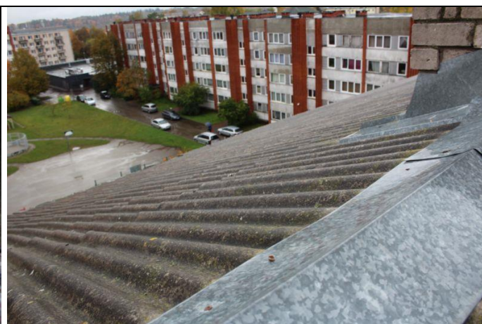
4.8.6. att. Azbestcimenta viļņoto lokšņu jumta segums, skārda jumta elementi
