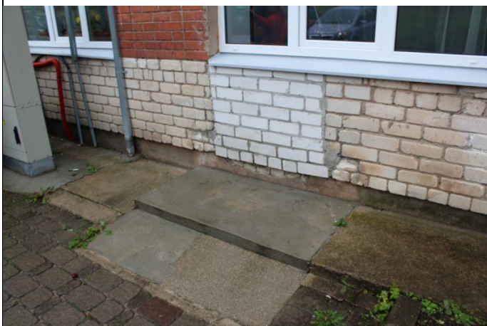
4.1.1. att. Betona aizsargapmale
