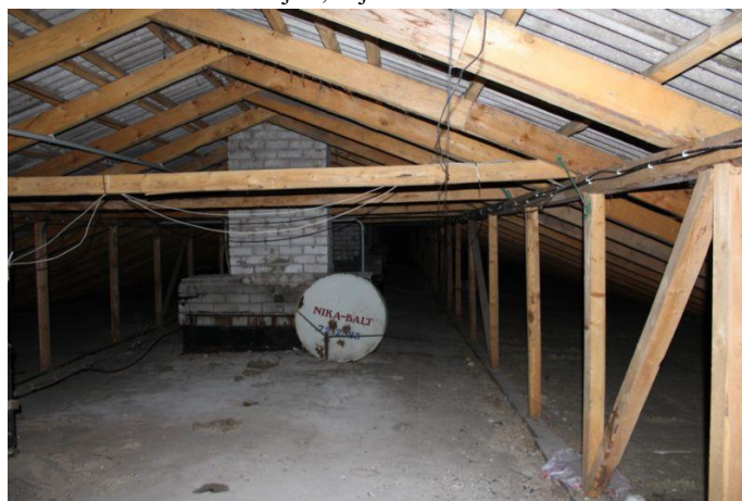
4.8.15.att. Jumta nesošās koka konstrukcijas
