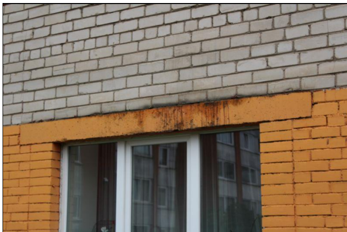
4.2.3. un 4.2.4. att. Ārsienas bojājumi mitruma un sala ietekmē – bioloģiskais apaugums
