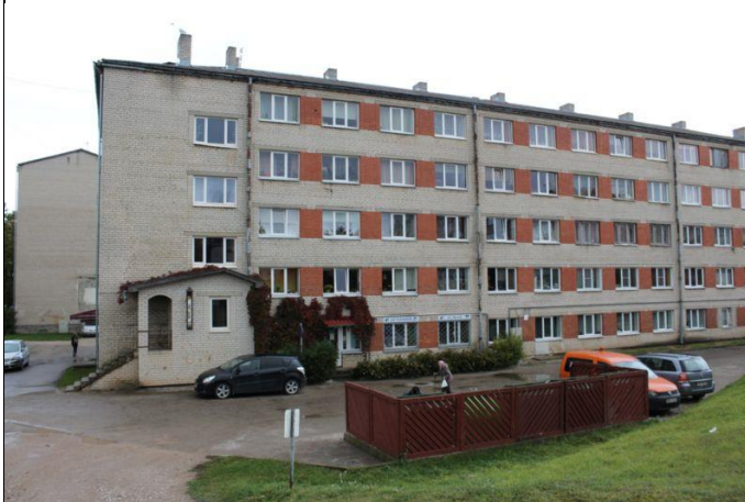
4.19.2. att. Ēkas rietumu puses fasāde
