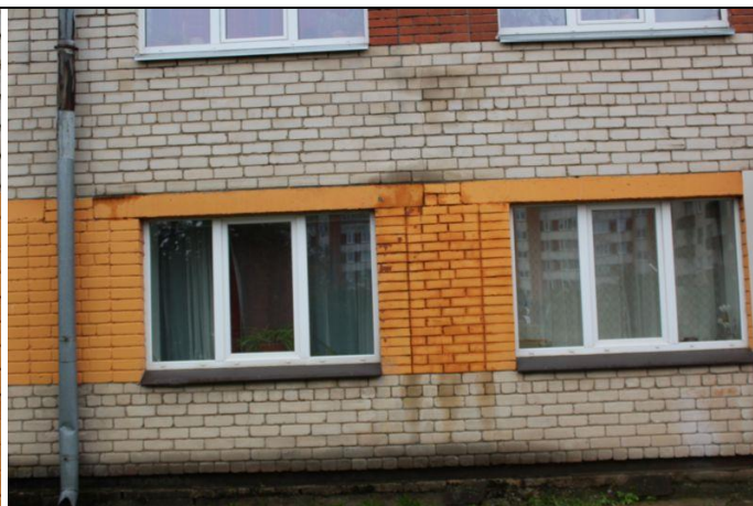
4.2.3. un 4.2.4. att. Ārsienas bojājumi mitruma un sala ietekmē – bioloģiskais apaugums
