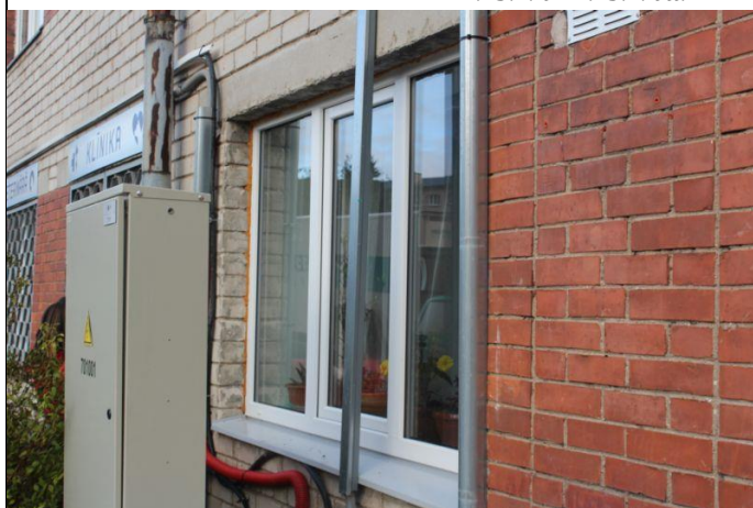
4.13.3. att. Elementi izvietoti aizsedzot logu
