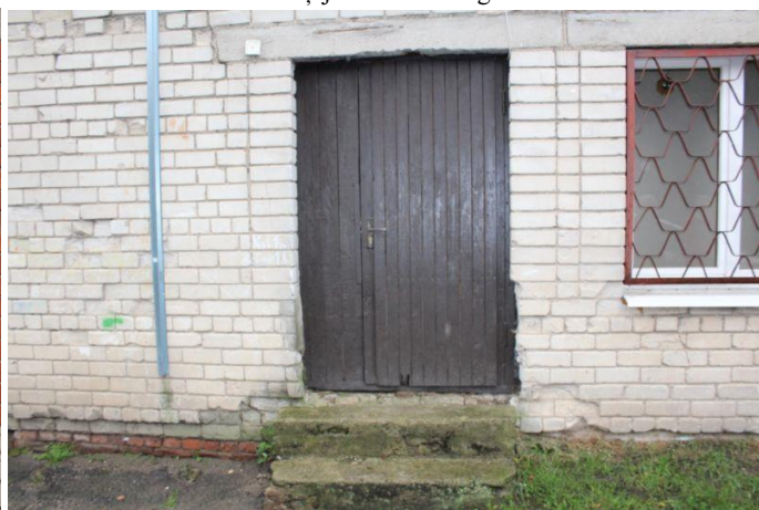
4.13.6. att. Novecojušas koka konstrukciju ārdurvis
