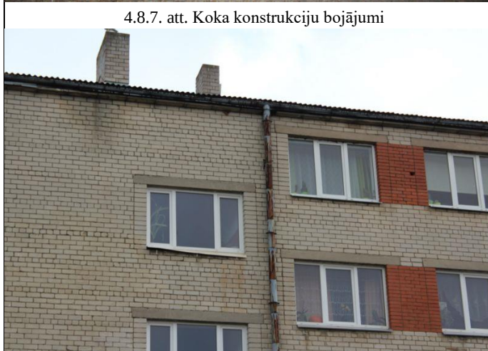
4.8.9. un 4.8.10. att. Novecojuši, bojāti lietus ūdens notek sistēmas elementi
