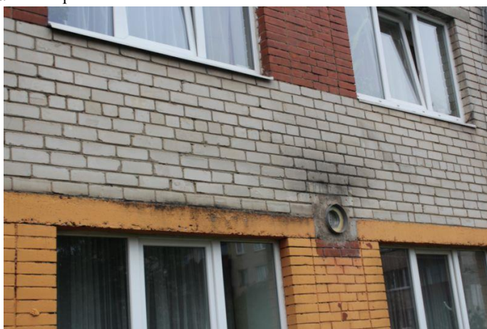
4.2.13. un 4.2.14. att. Ārsienas bojājumi mitruma un sala ietekmē – bioloģiskais apaugums
