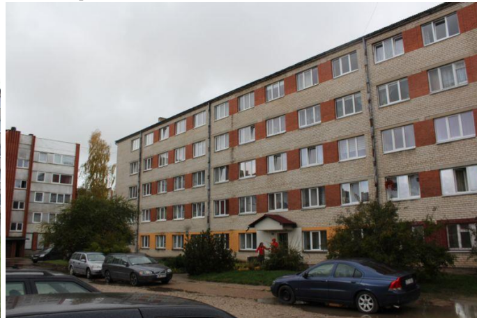
4.19.3. att. Ēkas dienvidu puses fasāde
