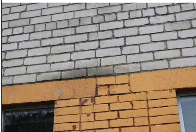
4.2.13. un 4.2.14. att. Ārsienas bojājumi mitruma un sala ietekmē – bioloģiskais apaugums
