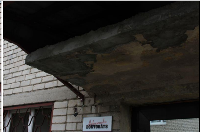
4.9.7. un 4.9.8.att. Dz betona ieejas jumtiņš
