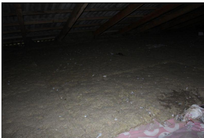
4.8.5.att. Siltināts bēniņu pārsegums
