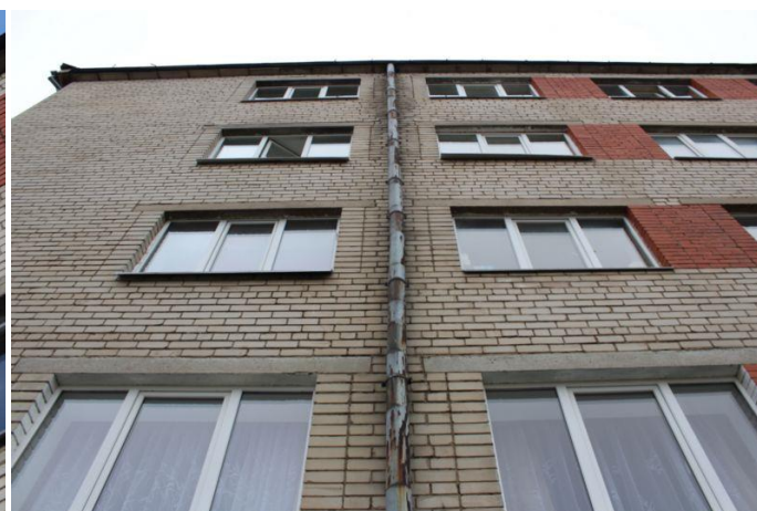
4.8.13. un 4.8.14.att. Novecojuši, bojāti lietus ūdens noteksisistēmas elementi
