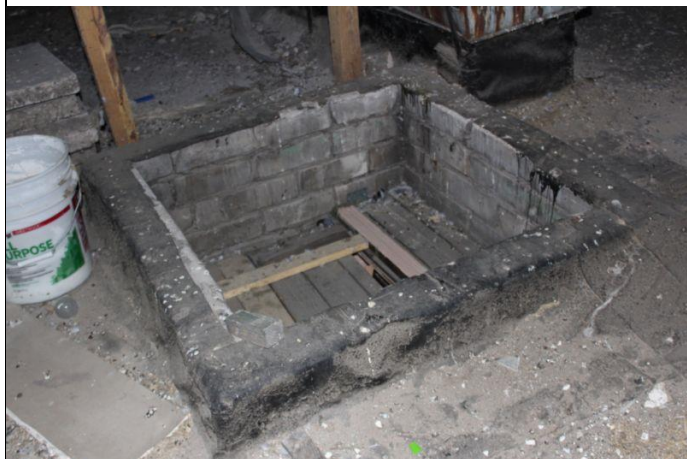
4.8.3. att. Lūka bēniņu pārsegumā
