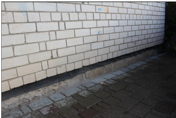
4.1.5. att. Horizontāla hidroizolācija
