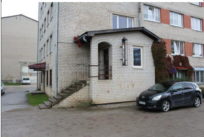
4.9.5. un 4.9.6.att. Ieejas mezglu jumtiņa segums, skārda elementi
