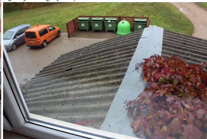
4.9.5. un 4.9.6.att. Ieejas mezglu jumtiņa segums, skārda elementi
