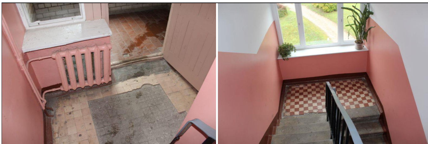
4.12.1. un 4.12.2. att. Kāpņu telpu betona plākšņu un betona klona grīda
