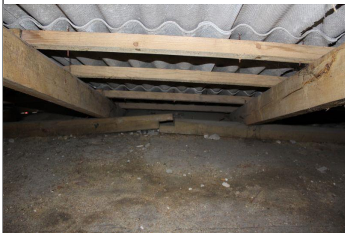
4.8.7. att. Koka konstrukciju bojājumi
