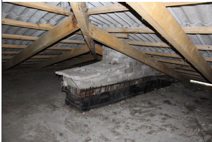
4.16.1. un 4.16.2. att. Ķieģeļu mūra ventilācijas šahtas
