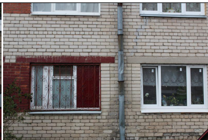
4.8.11.un 4.8.12.att. Novecojuši, bojāti lietus ūdens noteksisistēmas elementi
