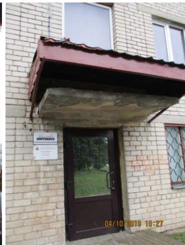
4.13.9. un 4.13.10. att. Metāla un PVC konstrukciju ārdurvis
