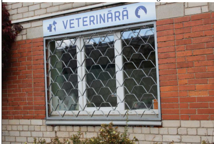
4.13.5. att. Montētas drošības restes
