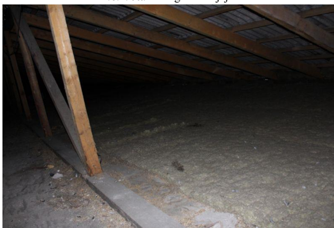
4.6.4. att. Siltināts bēniņu pārsegums
