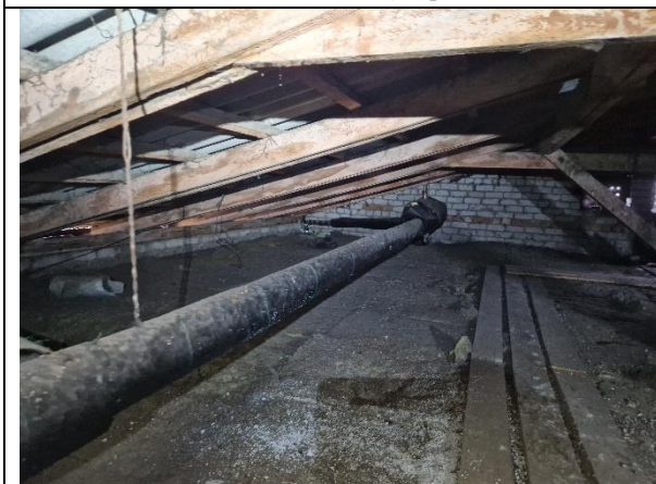
11. Apkures cauruļvadiem ēkas bēniņos novecojis siltumizolācijas slānis.
