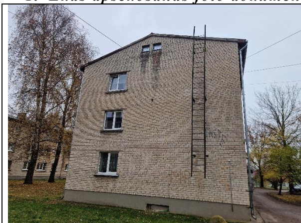
1.att. Ēkas Z fasāde
