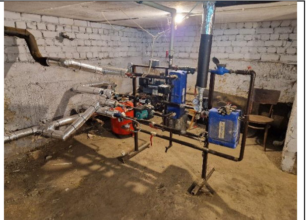
6. Ēkā uzstādīts neatkarīgā pieslēguma tipa siltummezgli, kurā tiek padots ēkas apkures loka siltumnesējs, kā arī tiek sagatavots karstais ūdens daļai dzīvokļu
