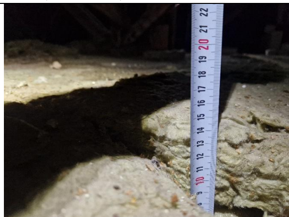
12. Ēkas bēniņu pārsegums siltināts ar aptuveni 13cm biezu siltumizolācijas slāni.
