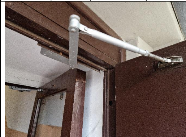
8.att. Veikta ārdurvju nomaiņa un kāpņu telpas logu nomaiņa. Netiek nodrošināta ārdurvju blīva aizvēršanās
