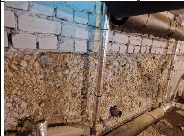
7.att. Apkures cauruļvadu siltumizolācija tiek uzturēta darba kārtībā, vietām veikta siltumizolācijas nomaiņa.
