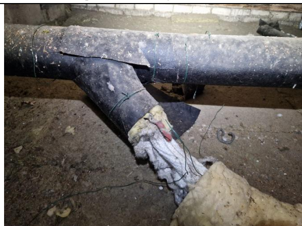
11. Apkures cauruļvadiem ēkas bēniņos novecojis siltumizolācijas slānis.
