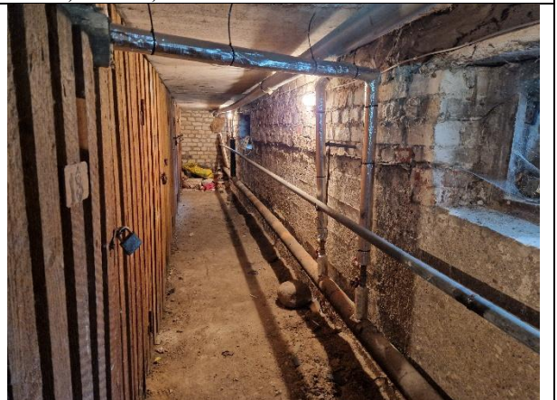
7.att. Apkures cauruļvadu siltumizolācija tiek uzturēta darba kārtībā, vietām veikta siltumizolācijas nomaiņa.
