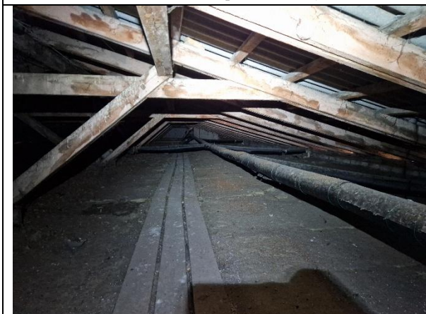
12. Ēkas bēniņu pārsegums siltināts ar aptuveni 13cm biezu siltumizolācijas slāni.
