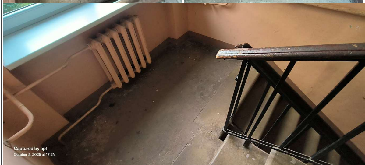
5.4. Elektroapgādes sistēma un elektrotehniskās ietaises. Vājstrāvas tīkli.
