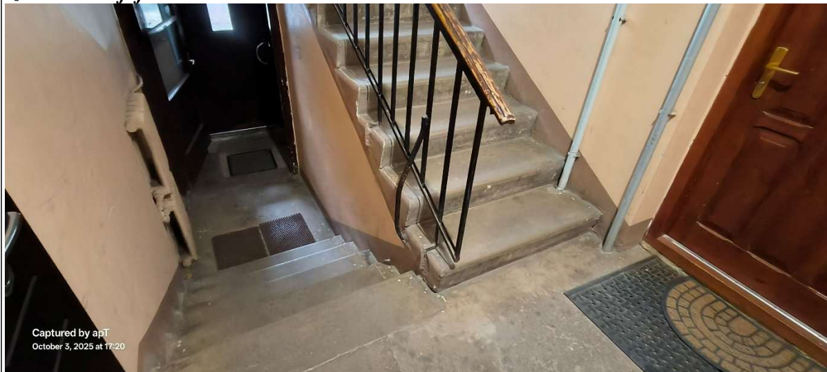
Kāpņu laidī, stāvu un starpstāvu pārsegumi no saliekamā dzelzsbetona, kas balstīti ķieģeļu mūros. Kāpnes aprīkotas ar metāla margām un koka lenteriem. Kāpnes un margas bez izteiktiem bojājumiem.
