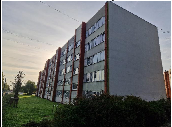
3.att. Ēkas R un A fasādes ir siltinātas
