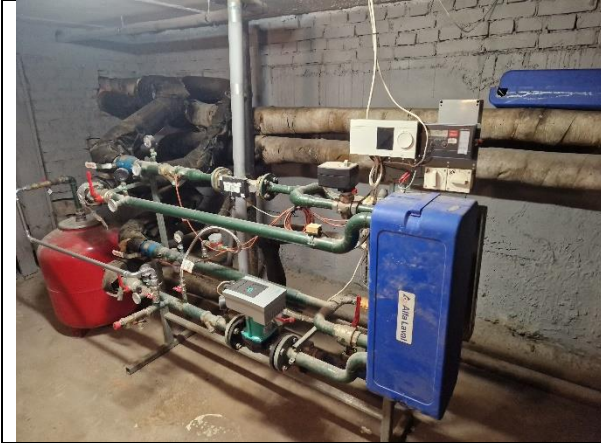
5. Ēkā uzstādīti divi neatkarīgā pieslēguma tipa siltummezgli, kuros tiek padots ēkas apkures loka siltumnesējs, kā arī tiek sagatavots karstais ūdens.
