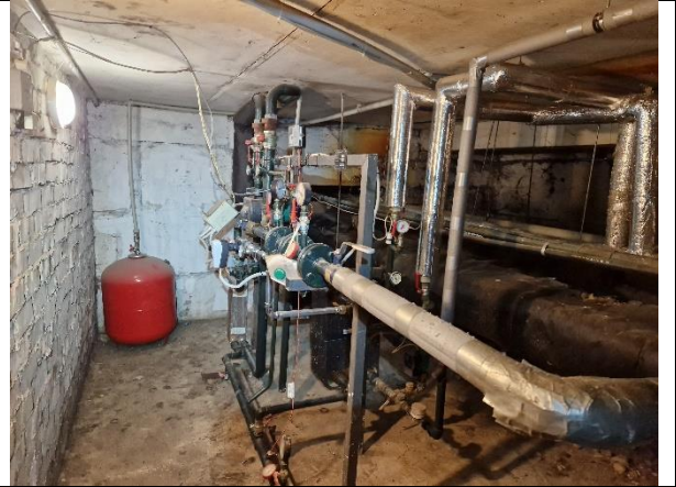
5. Ēkā uzstādīti divi neatkarīgā pieslēguma tipa siltummezgli, kuros tiek padots ēkas apkures loka siltumnesējs, kā arī tiek sagatavots karstais ūdens.
