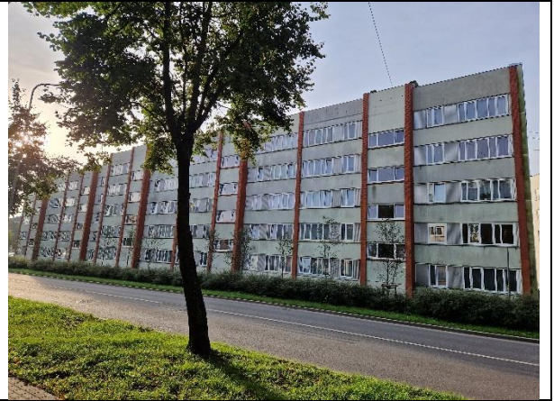
2.att. Ēkas Z fasāde.
