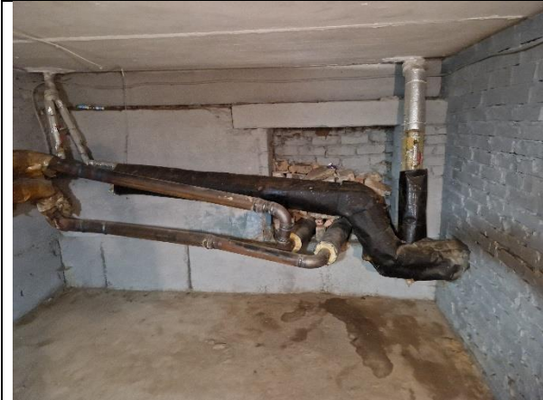
6.att. Veikta daļēja veco apkures cauruļvadu siltināšana
