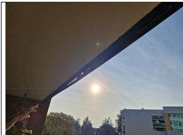
10.att. Lodžiju margas sliktā stāvoklī. Ieteicams veikt to demontāžu, jaunas margas izbūvi un lodžiju iestiklošanu
