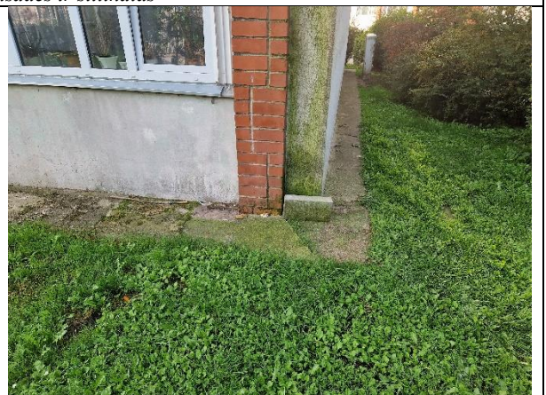
4.att. Nepieciešams veikt pamatu apmales atjaunošanu, lai nodrošinātu efektīvu lietus ūdens novadīšanas sistēmas darbību un nepieļautu ūdens uzkrāšanos un mitruma iesūkšanos pamatos
