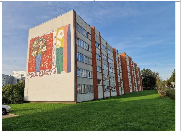
3.att. Ēkas R un A fasādes ir siltinātas
