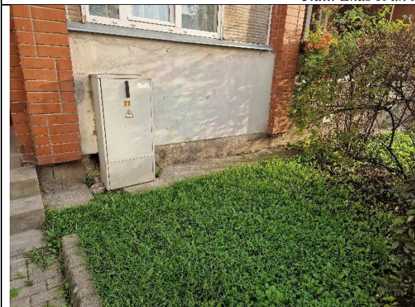
4.att. Nepieciešams veikt pamatu apmales atjaunošanu, lai nodrošinātu efektīvu lietus ūdens novadīšanas sistēmas darbību un nepieļautu ūdens uzkrāšanos un mitruma iesūkšanos pamatos
