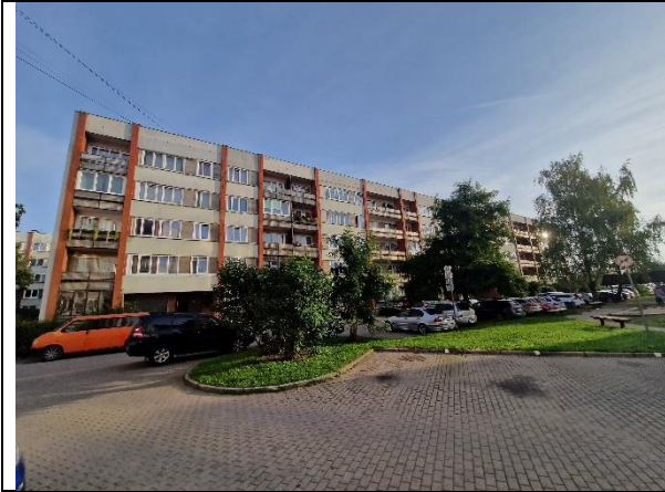
1.att. Ēkas D fasāde
