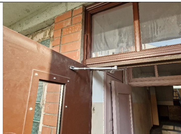
12.att. Veikta kāpņu telpas durvju nomaiņa un aizvērēj mehānismu montāža
