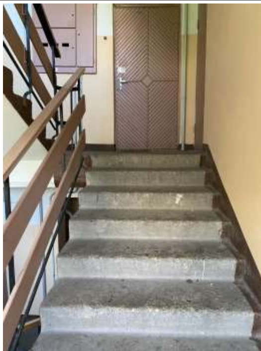
4.10.1.att. Dzelzsbetona konstrukciju starpstāvu kāpnes
