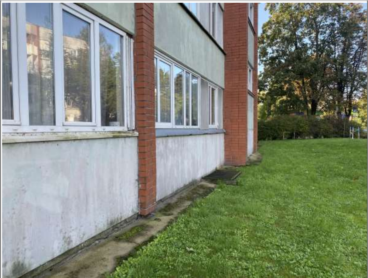
4.1.4. att. Ēkas pamatu apmales
