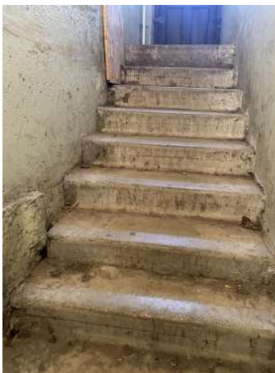
4.10.2.att. Dzelzsbetona konstrukciju pagraba kāpnes
