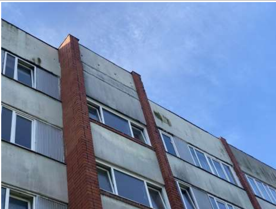
4.2.2.att. Sala, mitruma piesātinājuma bojājumi, bioloģiskais apaugums
