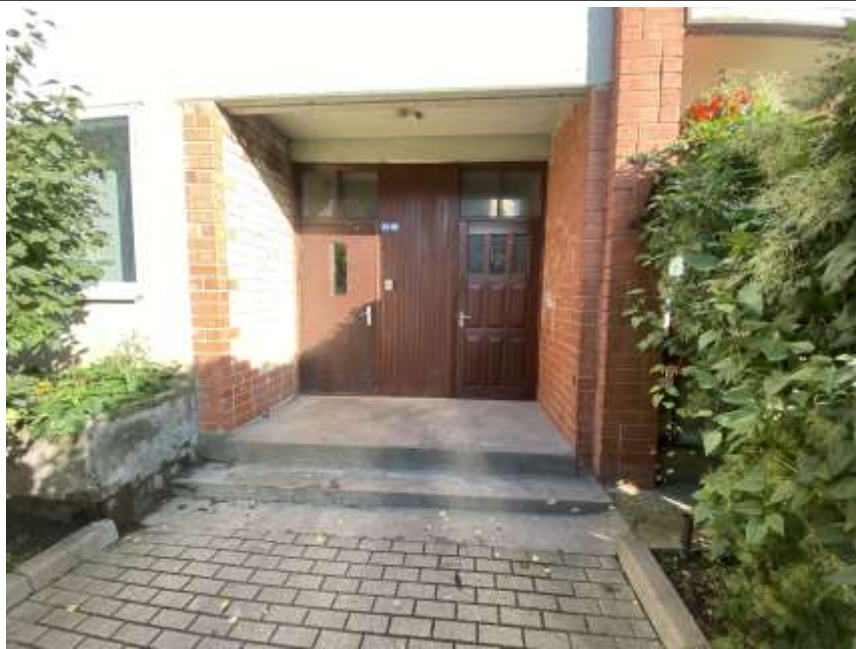
4.10.3.att. Dzelzsbetona konstrukciju ieejas kāpnēs
