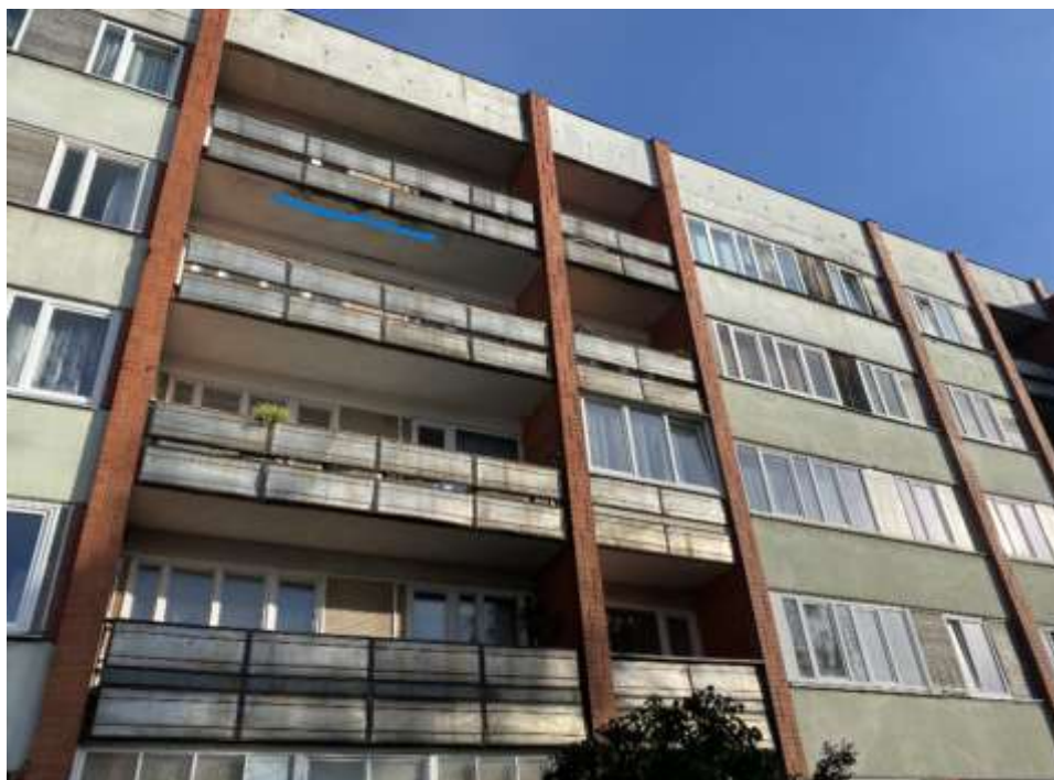
4.9.2.att. Lodžiju konstrukcijas
