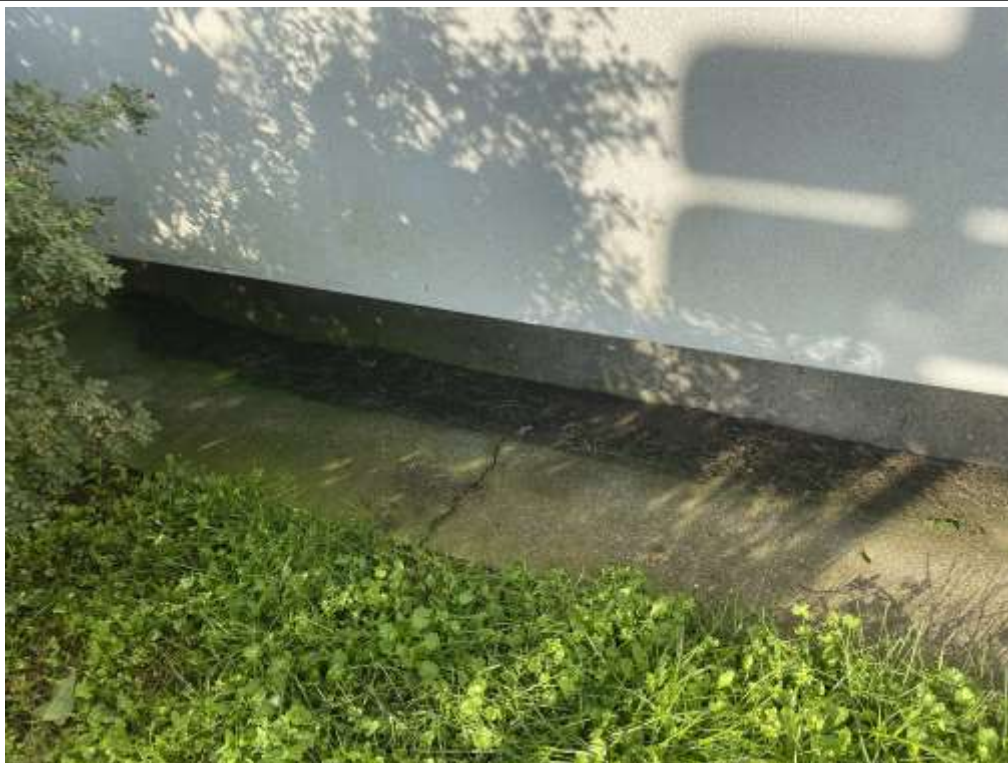
4.1.3. att. Ēkas pamatu apmales
