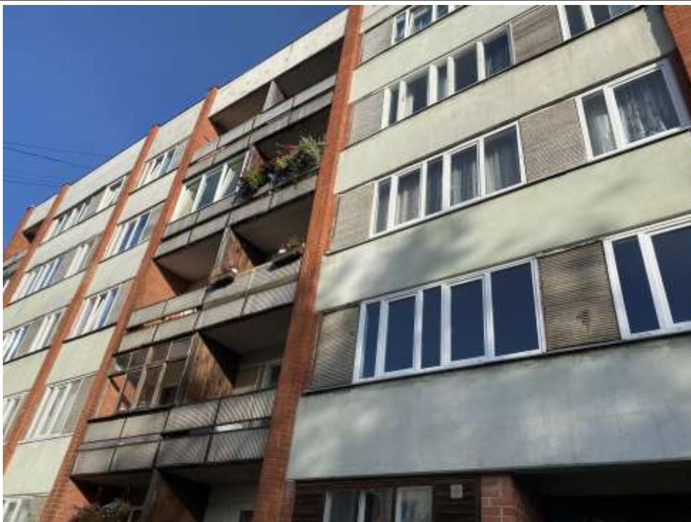
4.9.1.att. Lodžiju konstrukcijas
