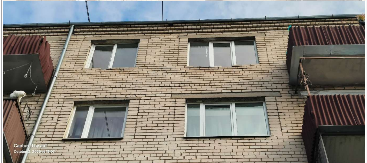
4.8. Iekšēja apdare. Ailu aizpildījumi: vārti, durvis, logi, lūkas. Vējtverī norobežo otrās koka durvis, bet dažās kāpņu telpās tās ir demontētas.
