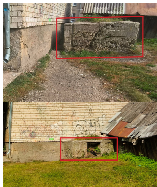
Demontējams betona pamats
