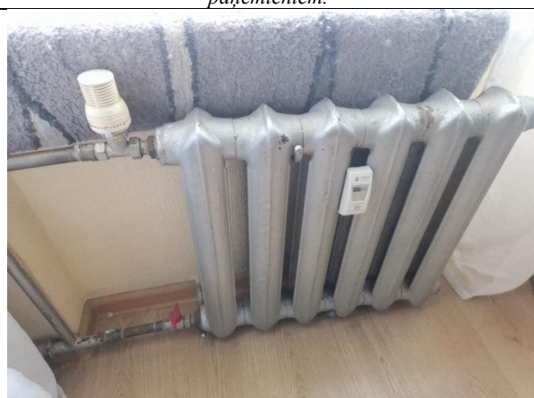
10.att. Ēkā ierīkota viencauruļu apkures sistēma. Sildķermeņi aprīkoti ar termostātisko ventili un siltuma maksas sadalītājiem.
