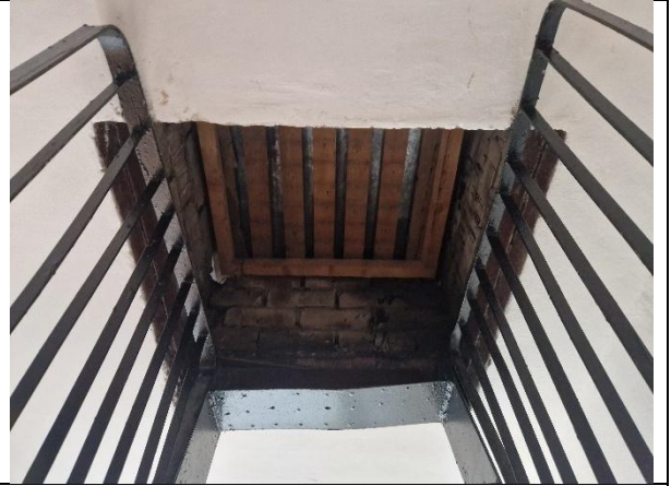
6.att. Jūma lūka ir novecojusi, ar zemu siltumnoturību, un to nav iespējams blīvi aizvērt, kā rezultātā tiek veicināta pārlieku augsta gaisa apmaiņa kāpņu telpā.
