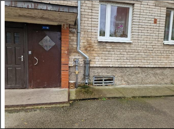
7.att. Ēkai nepieciešams veikt pamatu apmales un notekūdens novadīšanas sistēmas sakārtošanu, lai nodrošinātu mitruma aizvadīšanu no ēkas pamatiem.
