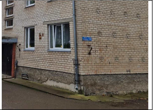
7.att. Ēkai nepieciešams veikt pamatu apmales un notekūdens novadīšanas sistēmas sakārtošanu, lai nodrošinātu mitruma aizvadīšanu no ēkas pamatiem.
