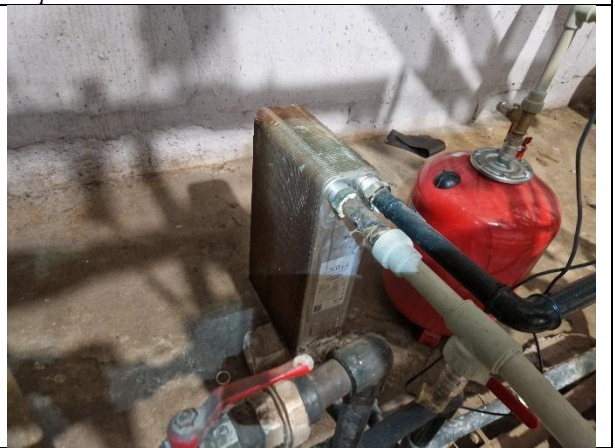
8.att. Siltumenerģija ēkā tiek uzskaitīta ar vienu siltumenerģijas skaitītāju. Siltumenerģijas padeve tiek regulēta atkarībā no āra gaisa temperatūras. Ierīkots neatkarīgā pieslēguma siltummezgls ar atsevišķu siltummaiņu karstā ūdens sagatavošanai. Ieteicams ierīkot atsevišķu karstā ūdens sagatavošanai paredzētu siltumenerģija skaitītāju, lai precīzāk būtu iespējams izvērtēt karstā ūdens patēriņa datus. Siltummaiņus nepieciešams aprīkot ar siltumizolācija čeholiem.
