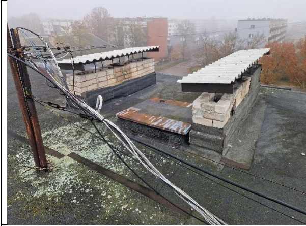
6.att. Jūma lūka ir novecojusi, ar zemu siltumnoturību, un to nav iespējams blīvi aizvērt, kā rezultātā tiek veicināta pārlieku augsta gaisa apmaiņa kāpņu telpā.
