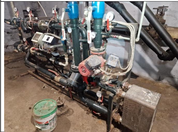
8.att. Siltumenerģija ēkā tiek uzskaitīta ar vienu siltumenerģijas skaitītāju. Siltumenerģijas padeve tiek regulēta atkarībā no āra gaisa temperatūras. Ierīkots neatkarīgā pieslēguma siltummezgls ar atsevišķu siltummaiņu karstā ūdens sagatavošanai. Ieteicams ierīkot atsevišķu karstā ūdens sagatavošanai paredzētu siltumenerģija skaitītāju, lai precīzāk būtu iespējams izvērtēt karstā ūdens patēriņa datus. Siltummaiņus nepieciešams aprīkot ar siltumizolācija čeholiem.
