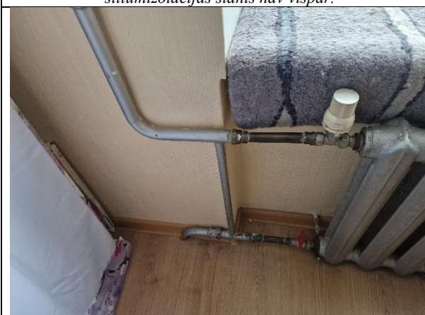
10.att. Ēkā ierīkota viencauruļu apkures sistēma. Sildķermeņi aprīkoti ar termostātisko ventili un siltuma maksas sadalītājiem.
