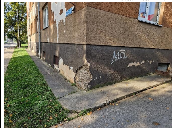
4.att. Nepieciešams veikt pamatu apmales un cokols atjaunošanu, lai nodrošinātu efektīvu lietussūknis novadīšanas sistēmas darbību un nepieļautu ūdens uzkrāšanos un mitruma iesūkšanos pamatos
