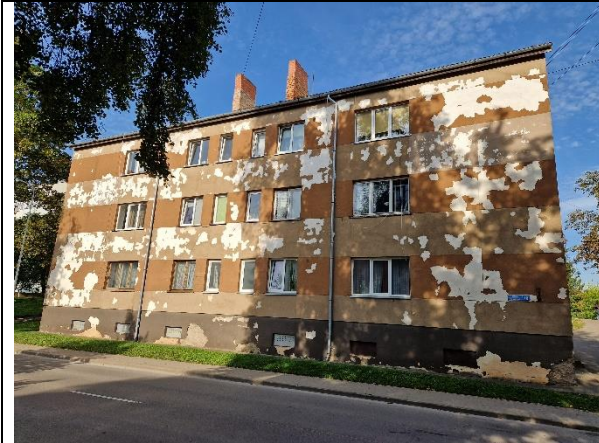
1.att. Ēkas D fasāde
