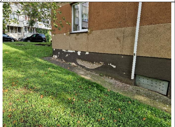
4.att. Nepieciešams veikt pamatu apmales un cokols atjaunošanu, lai nodrošinātu efektīvu lietussūknis novadīšanas sistēmas darbību un nepieļautu ūdens uzkrāšanos un mitruma iesūkšanos pamatos
