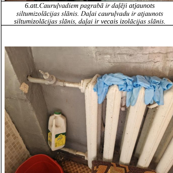
8.att. Ēkā ierīkota viencauruļu apkures sistēma
