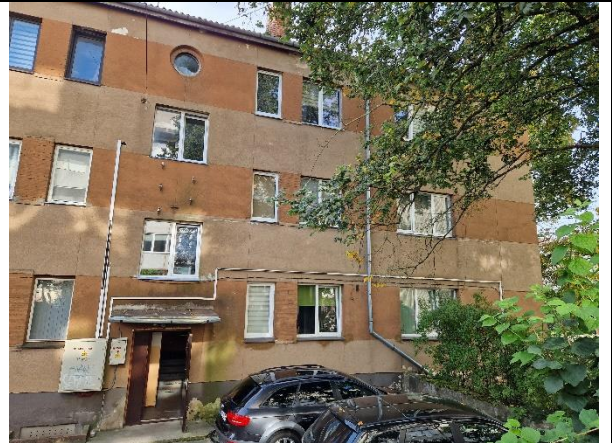
2.att. Ēkas Z fasāde.
