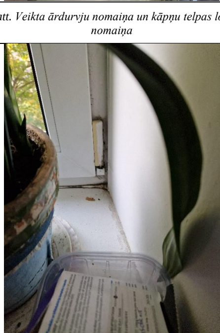
9.att. Atbilstoši iedzīvotāju sniegtajai informācijai, dažos dzīvokļos ir vērojama pelējuma sēnītes veidošanās.
