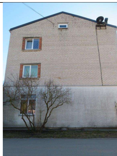
4.2.3. att. Ēkas ārsienas – apmetums 1.stāva līmenī
