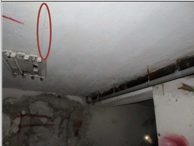
4.6.1. att. Pirmā stāva (pagraba) pārsegums
