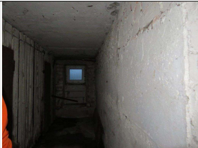
4.6.2. att. Pirmā stāva (pagraba) pārsegums
