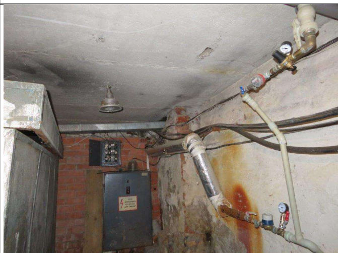
4.6.4. att. Pirmā stāva (pagraba) pārsegums
