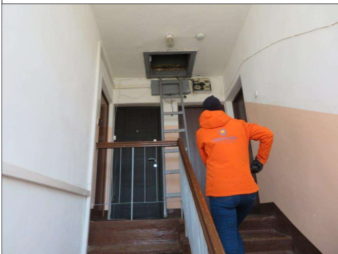
4.6.5. att. Trešā stāva (bēniņu) pārsegums
