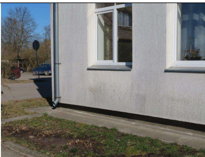
4.1.5. att. Pamatu aizsargapmale un lietus ūdens novadīšanas sistēma
