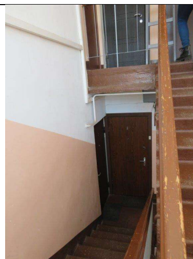
4.2.11. att. Nesošās sienas kāpņu telpā
