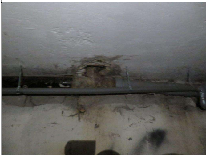
4.6.3. att. Pirmā stāva (pagraba) pārsegums
