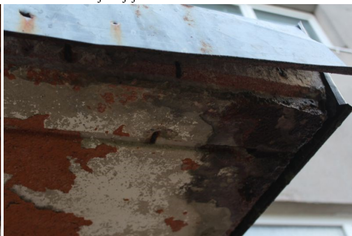
4.9.7. un 4.9.8. att. Ieejas mezglu jumtiņu dz-betona konstrukciju bojājumi
