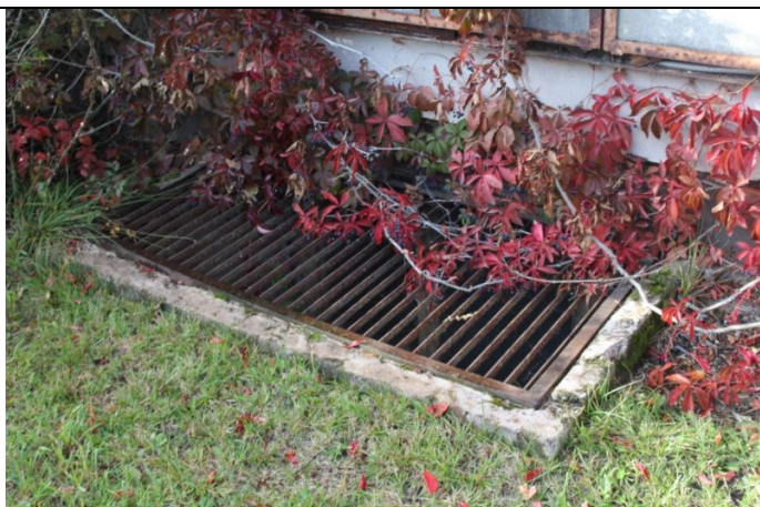
4.1.7.att. Dz.- betona konstrukciju gaismas šahtas
