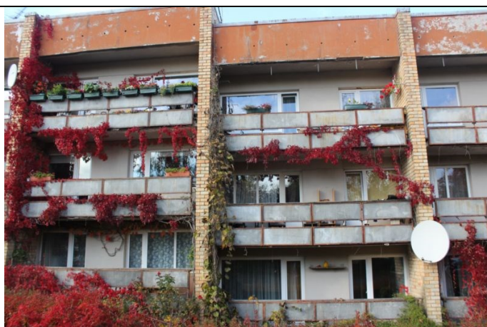
4.13.3 un 4.13.4. att. Nav ievērots vienots ailu aizpildījums
