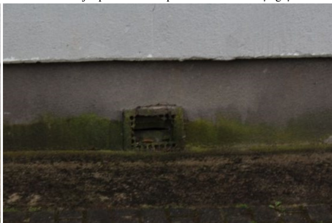
4.1.4. un 4.1.5. att. Pagraba ventilācijas atvērumu nosegelementi
