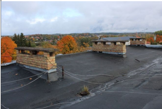
4.8.5. att. Ķieģeļu mūra viršjūmta ventilācijas izvadi
