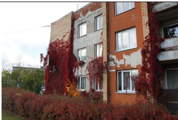
4.2.4. un 4.2.4. att. Vieglobetona un ķieģeļu mūra āršienu bojājumi
