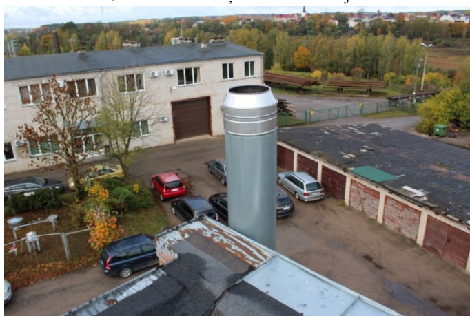
5.4.6. att. Dūmkanāla virsjumta izvads
