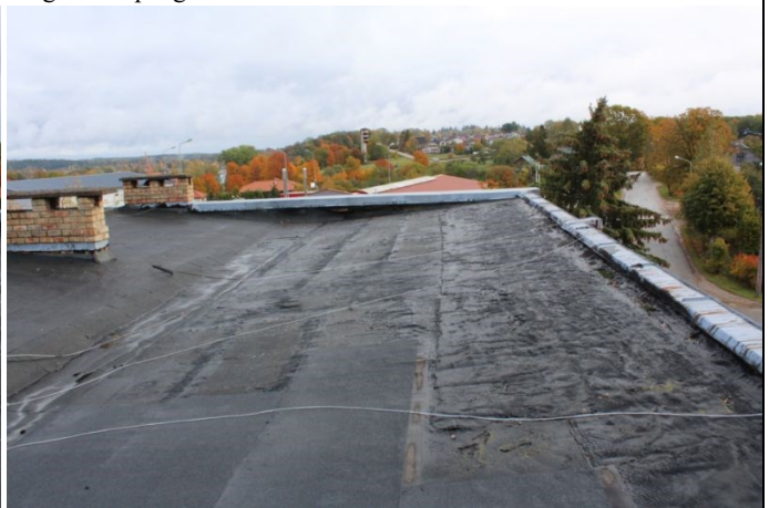
4.8.6. att. Bitumena ruļļmateriāla jumta segums
