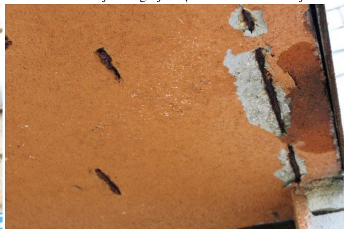
4.9.11. un 4.9.12. att. Lodžiju dz-betona konstrukciju bojājumi
