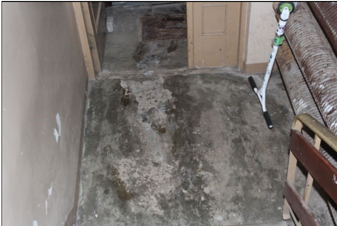
4.12.1.att. Kāpņu telpu betona klona grīda
