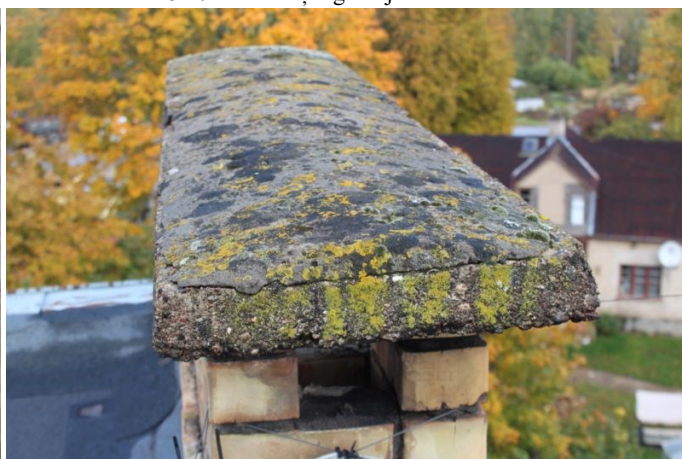
4.8.12. att. Virsjumta ventilācijas izvadu nosegelements
