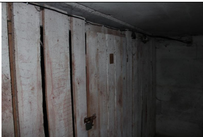
4.2.4. att. Koka konstrukciju starpsiena pagrabstāvā
