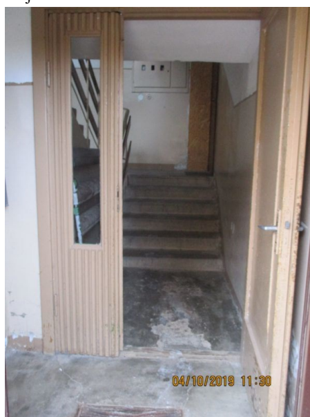
4.13.7. att. Koka konstrukciju vājtveru durvis
