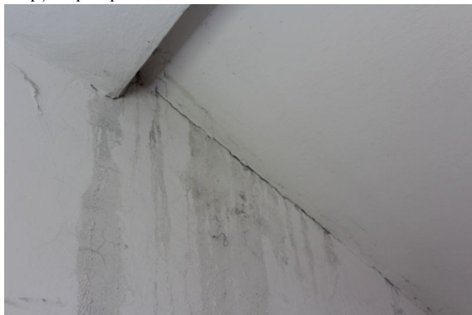
4.18.3. un 4.18.4. att. Kāpņu telpas apdares bojājumi
