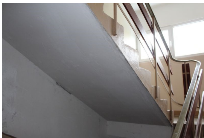
4.10.2. att. Dzelzsbetona konstrukciju starpstāvu kāpnes
