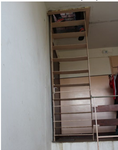
4.10.5. att. Jumta lūka aprīkota ar metāla kāpnēm
