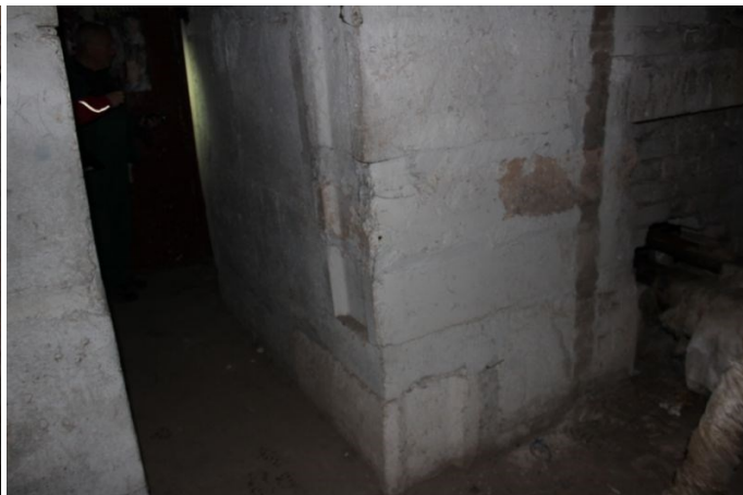
4.1.1. un 4.1.2. att. Dz-betona bloku pamati
