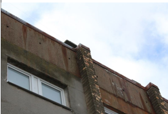
4.2.1. un 4.2.2. att. Sala, mitruma piesātinājuma bojājumi, bioloģiskais apaugums
