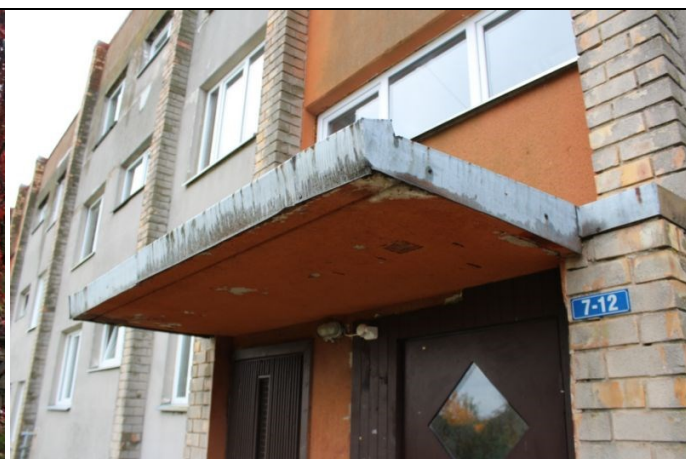
4.9.10. att. Ieejas mezglu jumtiņu dz-betona konstrukcijas
