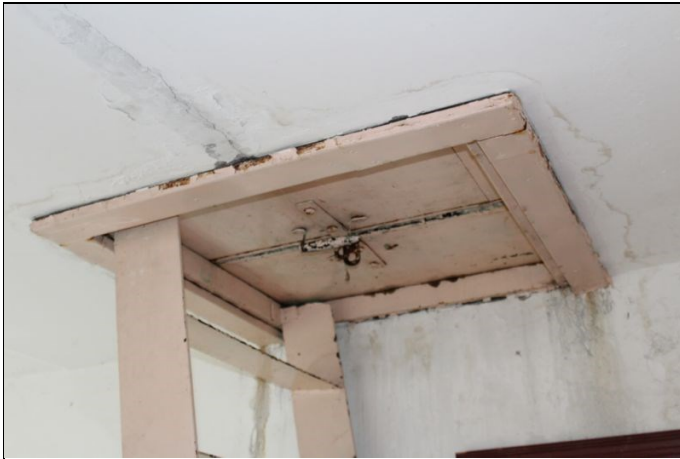
4.8.1. un 4.8.2. att. Lūka nonākšanai viršjūmta daļā
