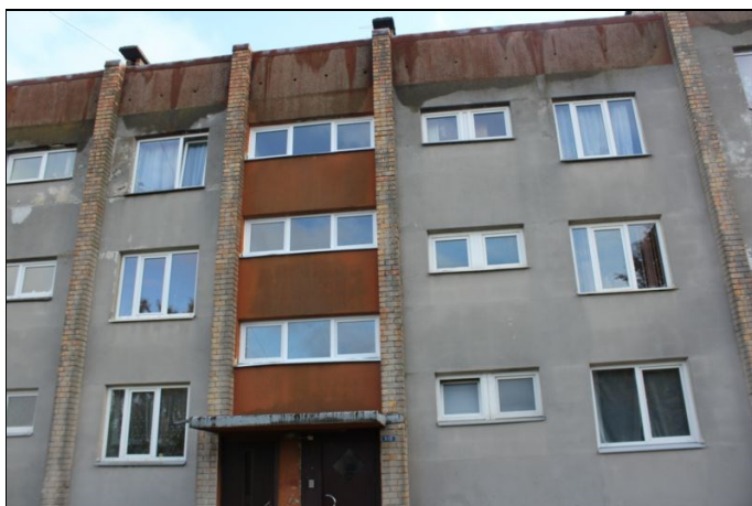
4.13.3 un 4.13.4. att. Nav ievērots vienots ailu aizpildījums
