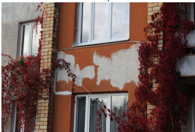
4.19.6. un 4.19.7. att. Ārējās apdares bojājumi
