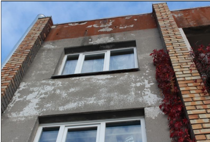
4.19.8. un 4.19.9. att. Ārējās apdares bojājumi
