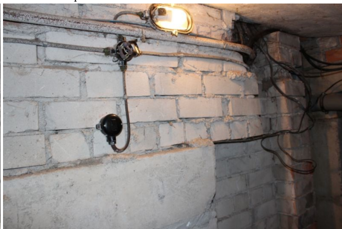
4.1.3. att. Virsējās pamatu kārtas piemūrētas ar silikātķieģeļiem
