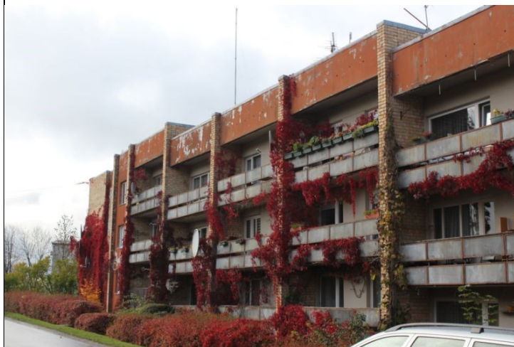
4.19.2. att. Ēkas dienvidu puses fasāde
