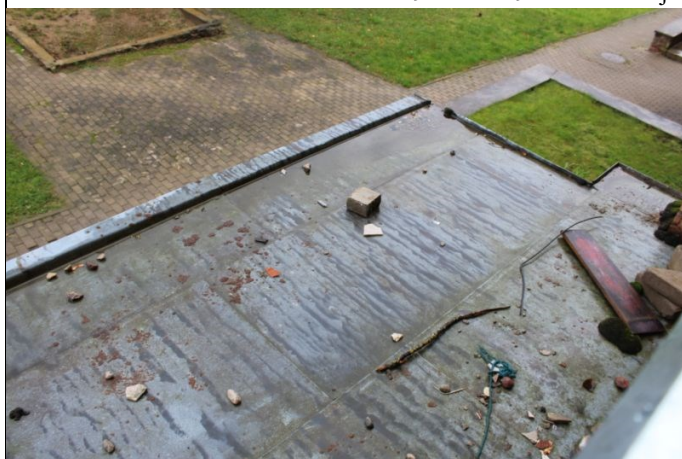
4.9.13. un 4.9.14. att. Ieejas mezglu jumtiņu segums, bioloģiskais apaugums, gruži uz jumtiņu virsmas
