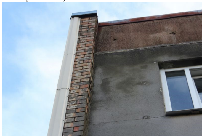
4.2.7. un 4.2.8. att. Austrumu puses gala āršienas profilēto lokšņu apdare
