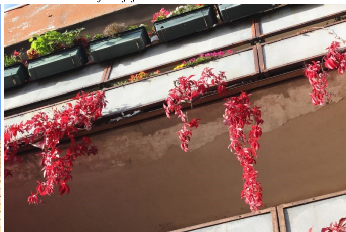
4.9.5. un 4.9.6. att. Lodžiju dz-betona konstrukciju bojājumi
