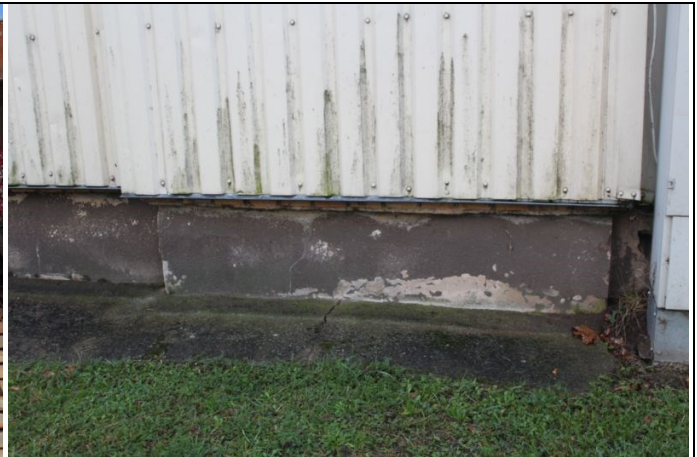
4.19.8. un 4.19.9. att. Ārējās apdares bojājumi
