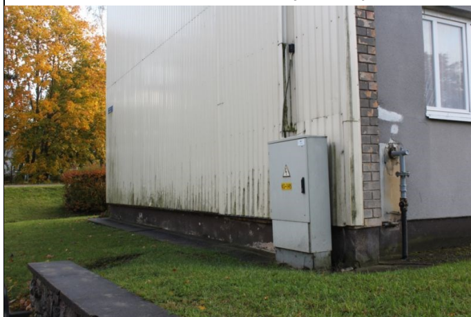
4.2.7. un 4.2.8. att. Austrumu puses gala āršienas profilēto lokšņu apdare
