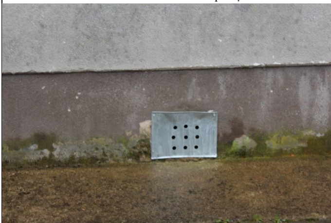
4.1.4. un 4.1.5. att. Pagraba ventilācijas atvērumu nosegelementi
