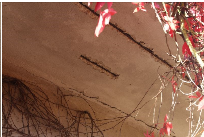
4.9.3. att. 4.9.4. att. Lodžiju dz-betona konstrukciju bojājumi
