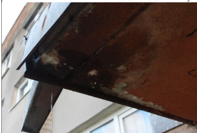
4.9.7. un 4.9.8. att. Ieejas mezglu jumtiņu dz-betona konstrukciju bojājumi
