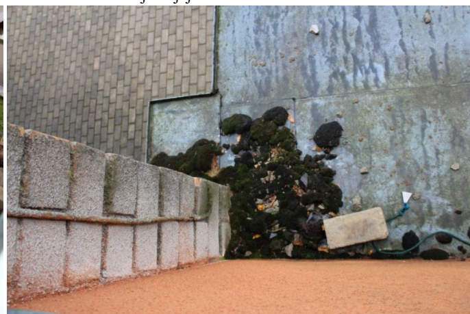
4.9.13. un 4.9.14. att. Ieejas mezglu jumtiņu segums, bioloģiskais apaugums, gruži uz jumtiņu virsmas
