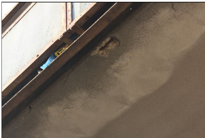
4.9.3. att. 4.9.4. att. Lodžiju dz-betona konstrukciju bojājumi
