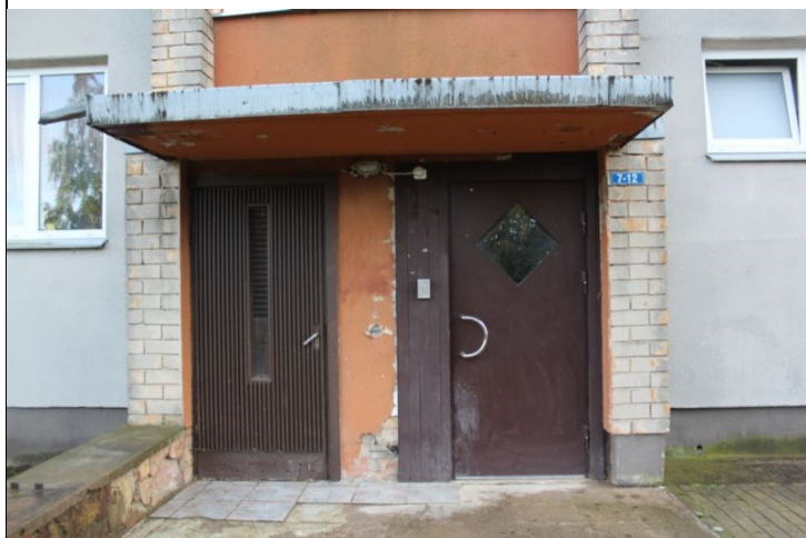
4.13.5. att. Koka un metāla konstrukciju ārdurvis
