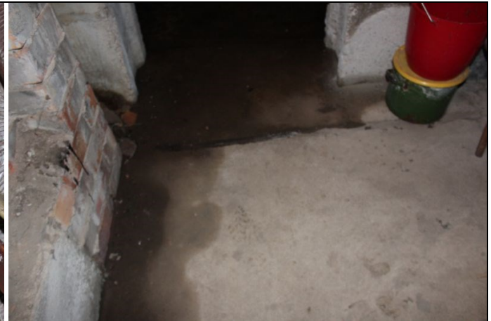
4.12.2. att. Pagrabstāva betona klona grīda
