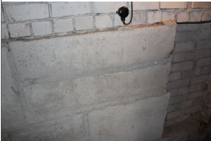
4.1.1. un 4.1.2. att. Dz-betona bloku pamati
