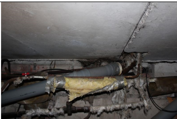
5.1.2. att. Atjaunots kanalizācijas sistēmas cauruļvadu posms
