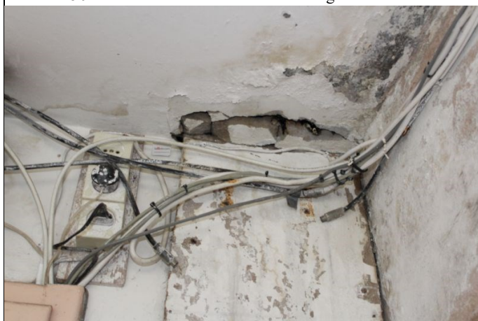
4.8.11. att. Caurtecējumu radītie bojājumi
