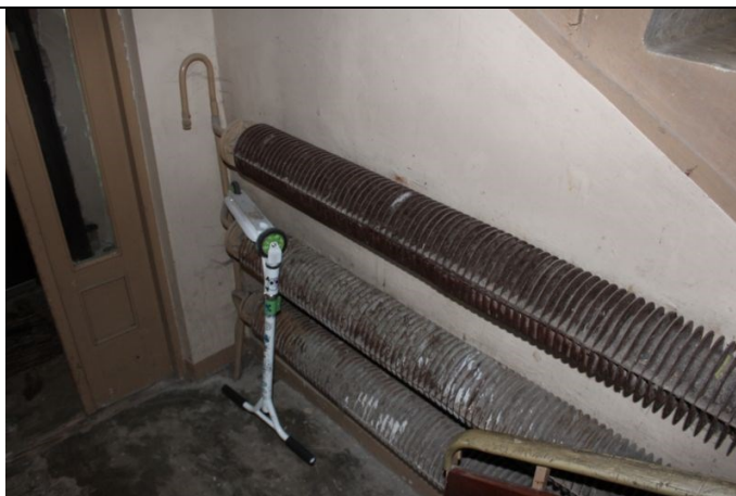
5.4.7. att. Metāla konvektori kāpņu telpās
