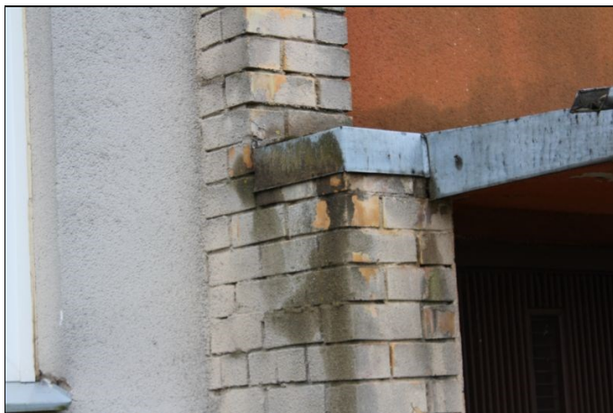
4.2.4. un 4.2.4. att. Vieglobetona un ķieģeļu mūra āršienu bojājumi
