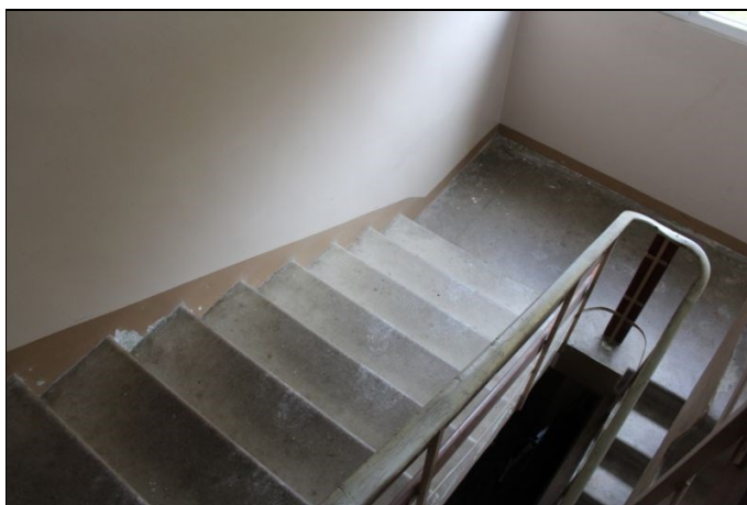
4.10.3. att. 4.10.4. att. Dzelzsbetona konstrukciju starpstāvu kāpnēs, lenteris
