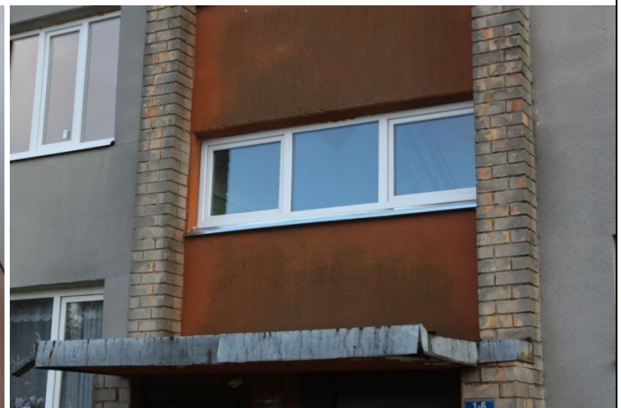
4.13.1. un 4.13.2. att. PVC konstrukciju kāpņu telpu logi
