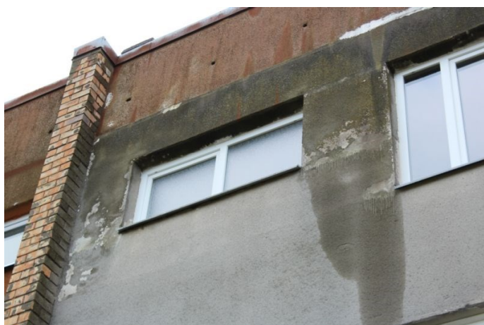
4.2.1. un 4.2.2. att. Sala, mitruma piesātinājuma bojājumi, bioloģiskais apaugums
