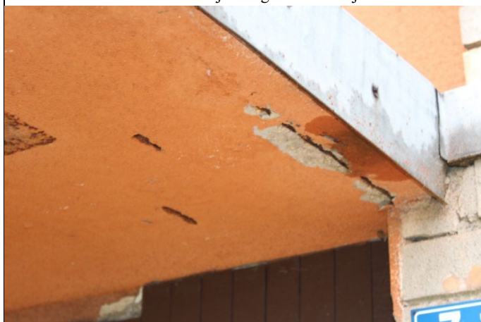
4.9.11. un 4.9.12. att. Lodžiju dz-betona konstrukciju bojājumi
