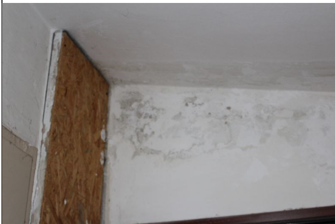
4.18.3. un 4.18.4. att. Kāpņu telpas apdares bojājumi
