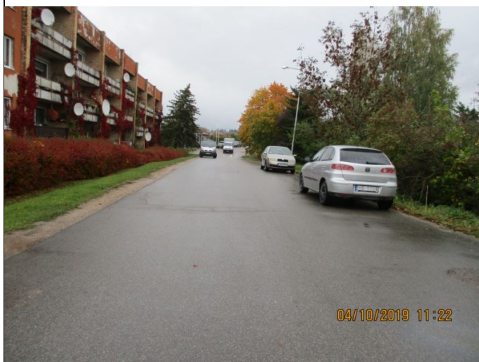
3.1.1.att. Piebraucamais ceļš – asfaltbetona segums
