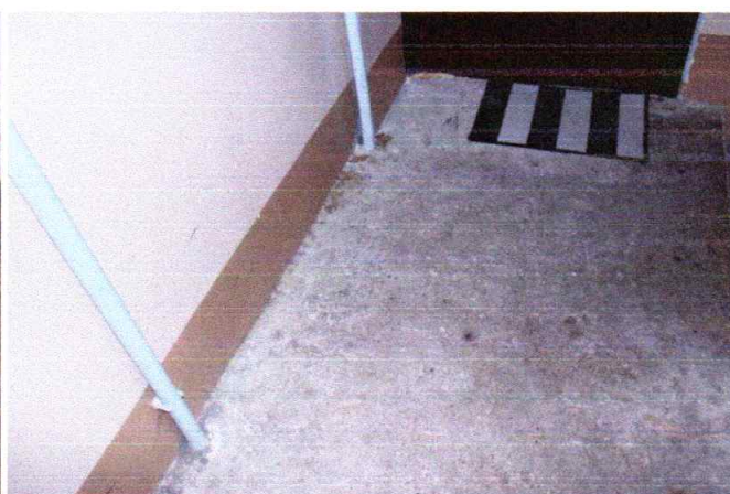
4.12.2. att. Kāpņu telpu betona klona grīda
