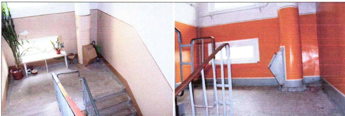
4.18.3. un 4.18.4. att. Kāpņu telpas sienu, grīdu un griestu apdare
