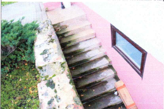
4.10.3.att. Dz-betona konstr. kāpnes noejai pagrabstāvā
