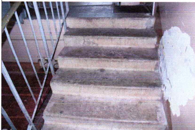
4.10.1. un 4.10.2.att. Starpstāvu dz-betona konstr. kāpnes
