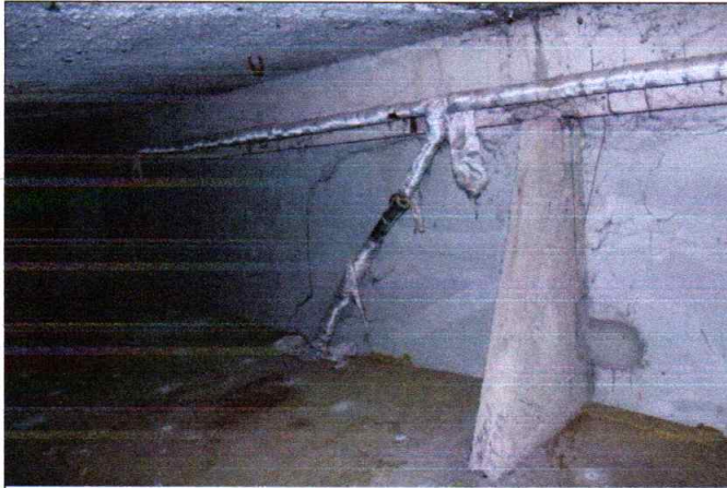
4.8.2. un 4.8.3. att. Jumta paneļi un satekne nobalstīti uz dzelzsbetona konstrukcijām un ārsienām
