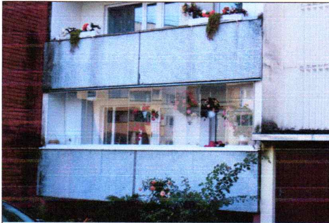
4.13.11. att. Lodžiju ailu aizpildījums
