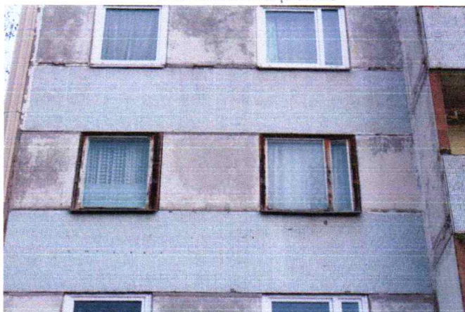
4.13.3. un 4.13.4. att. Novecojuši koka konstrukciju logi un durvis
