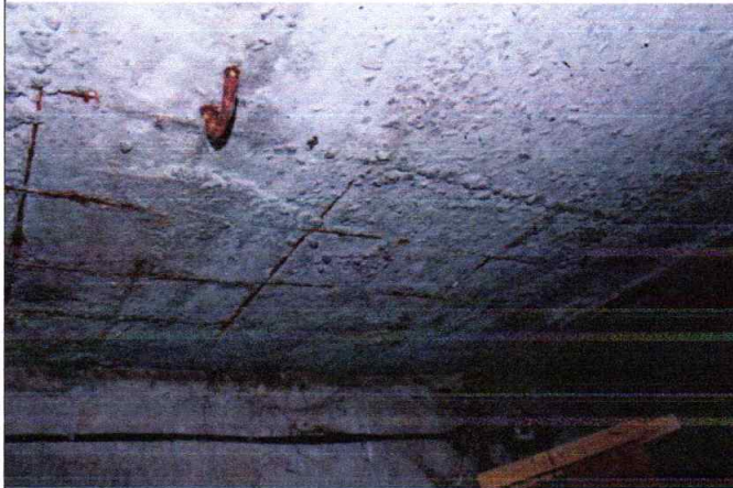
4.8.4. un 4.8.5. att. Jumta paneļi – bojāta betona aizsargkārtā, atsegts tērauda stiegriņš
