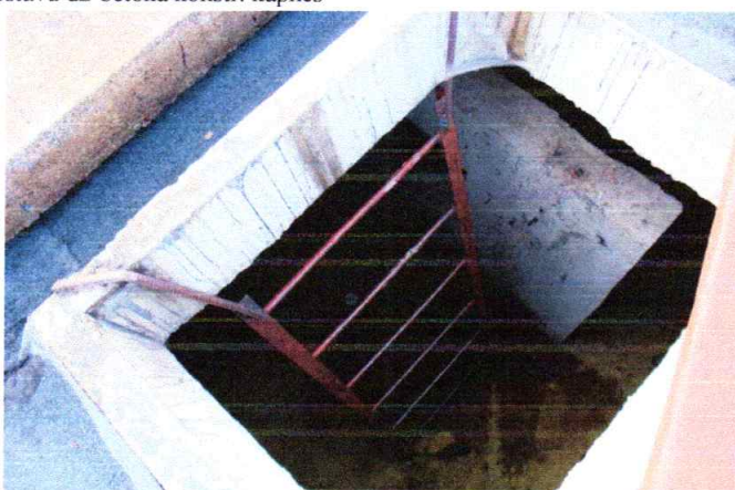
4.10.4. att. Jumta lūka ar pārvietojamām metāla kāpnēm
