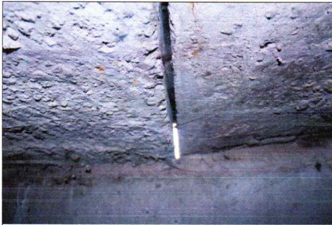
4.8.20.att.Nehermētiska paneļu savienojumu vieta
