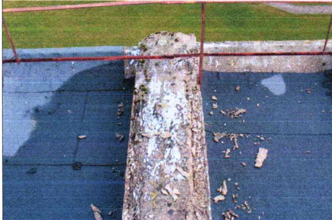
4.8.12.att. Dz-betona jumta elementu erozija
