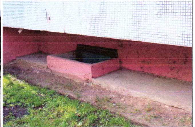
4.1.10. att. Dz.-betona konstrukciju gaismas šahtas
