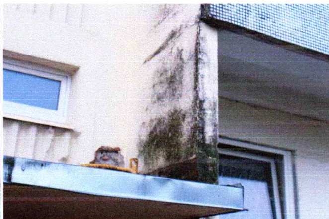
4.2.1. un 4.2.2. att. Sala, mitruma piesātinājuma bojājumi ārsienu konstrukcijās
