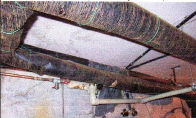
5.4.5. un 5.4.6. att. Apkures cauruļvadi ar izolāciju ēkas pagrabstāvā
