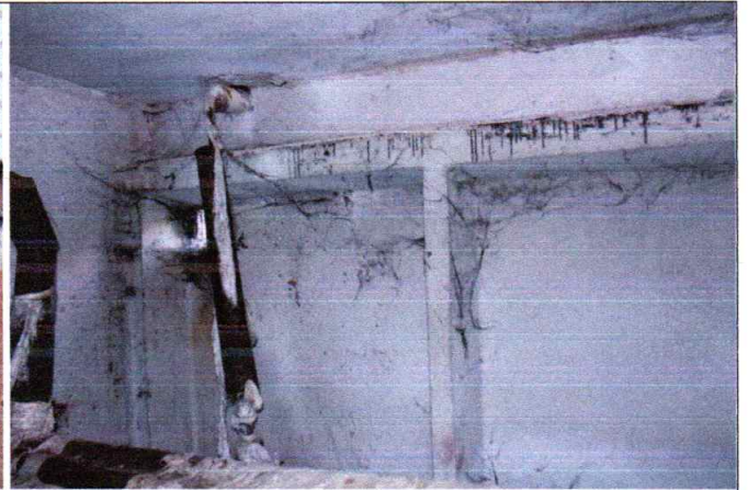
4.1.8. att. Ribotie cokola paneli
