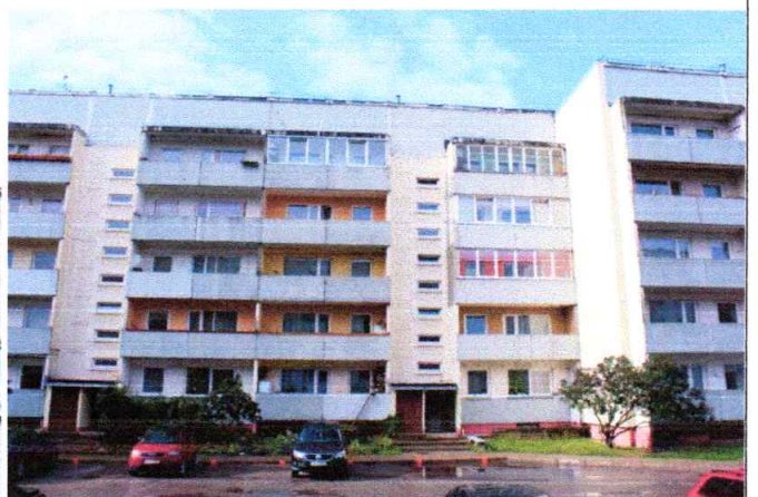
4.9.1. un 4.9.2.att. Iestiklotas un vaļējas lodžijas
