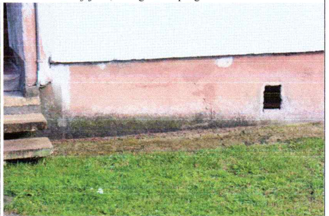
4.1.5. un 4.1.6. att. Mitrums uzkrājas pamatu konstrukcijās
