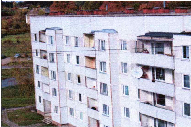
4.2.15. att. Ārsienu vieglbetona paneļi
