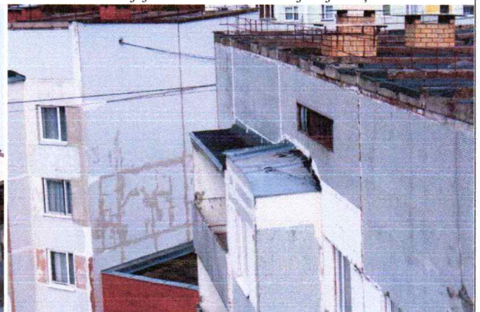
4.9.7. un 4.9.8. att. Piekta stāva lodžiju jumtiņu segumi
