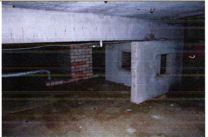
4.8.2. un 4.8.3. att. Jumta paneļi un satekne nobalstīti uz dzelzsbetona konstrukcijām un ārsienām
