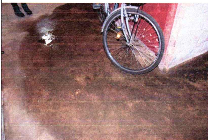
4.12.1. att. pagrabstāva betona klona grīda
