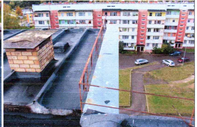
4.8.13. att. Parapeti apšūti ar skārda elementiem
