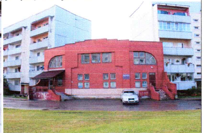
4.2.16. att. Keramisko ķieģeļu mūra konstrukcijas
