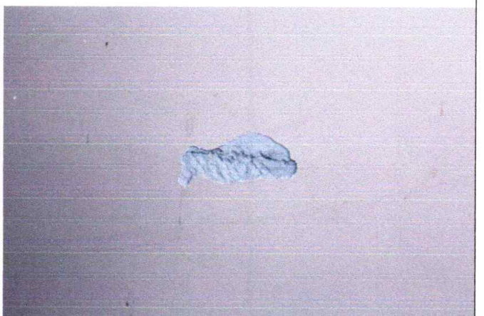
4.18.1. un 4.18.2. att. Lokāli iekšējās apdares bojājumi
