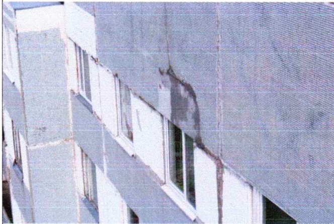
4.2.13. un 4.2.14. att. Mitruma bojājumi paneļu savienojuma vietās
