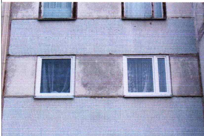
4.2.1. un 4.2.2. att. Sala, mitruma piesātinājuma bojājumi ārsienu konstrukcijās
