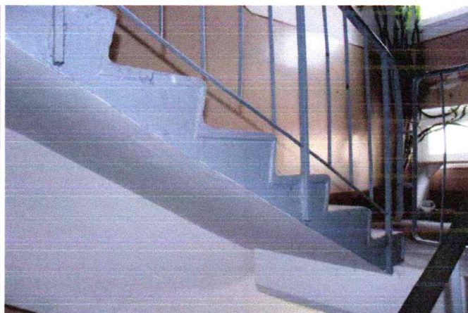
4.10.1. un 4.10.2.att. Starpstāvu dz-betona konstr. kāpnes
