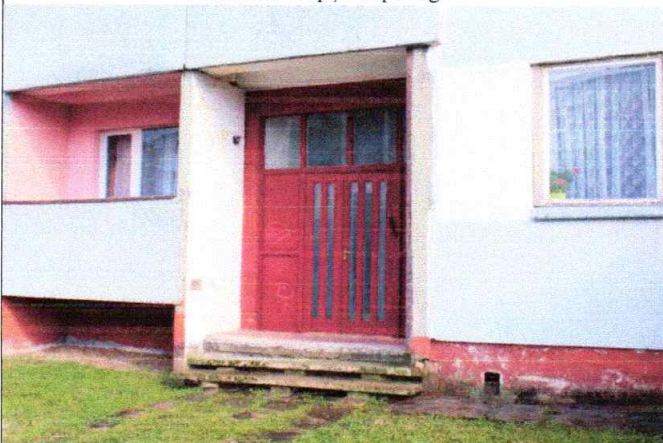
4.13.3. un 4.13.4. att. Novecojuši koka konstrukciju logi un durvis
