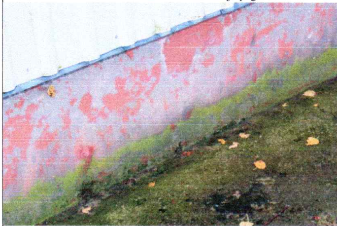
4.1.5. un 4.1.6. att. Mitrums uzkrājas pamatu konstrukcijās
