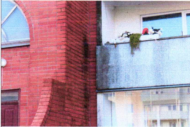
4.2.19. un 4.2.20. att. Mitrums uzkrājas ārēsienu konstrukcijās
