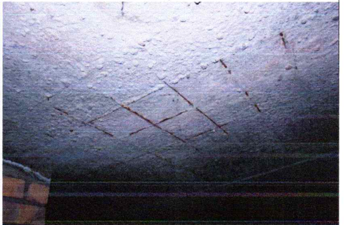
4.8.4. un 4.8.5. att. Jumta paneļi – bojāta betona aizsargkārtā, atsegts tērauda stiegriņš
