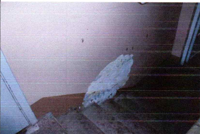
4.18.1. un 4.18.2. att. Lokāli iekšējās apdares bojājumi
