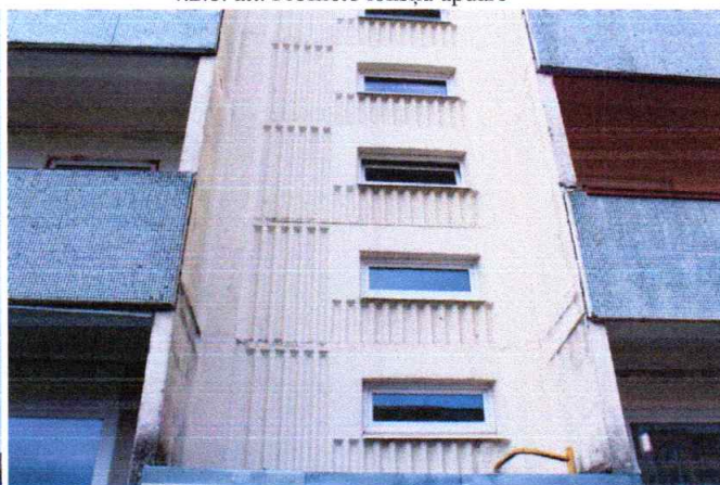
4.2.10. att. Ārsienu vieglbetona paneļi
