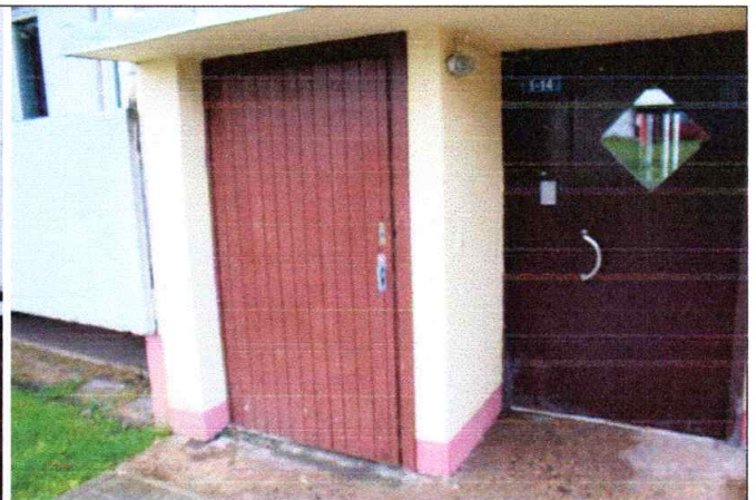
4.13.12. att. Novecojušas koka un metāla konstr. ārdurvis
