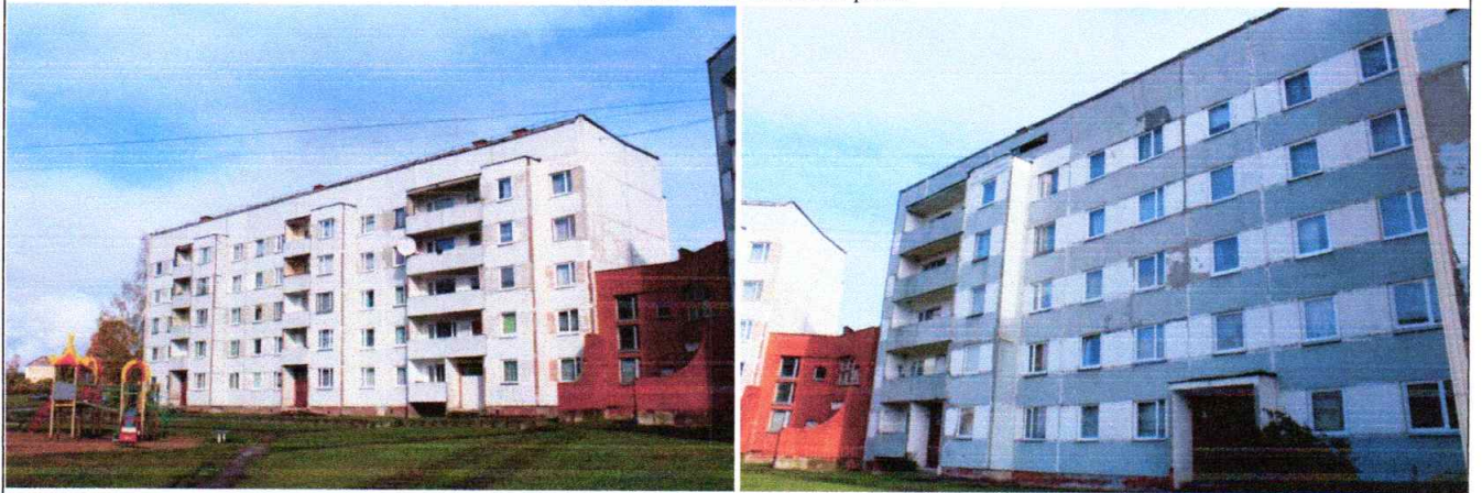
4.19.2. un 4.19.3. att. Ēkas rietumu puses sānu fasādes
