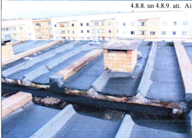
4.8.10. att. Bojāts bitumena segums
