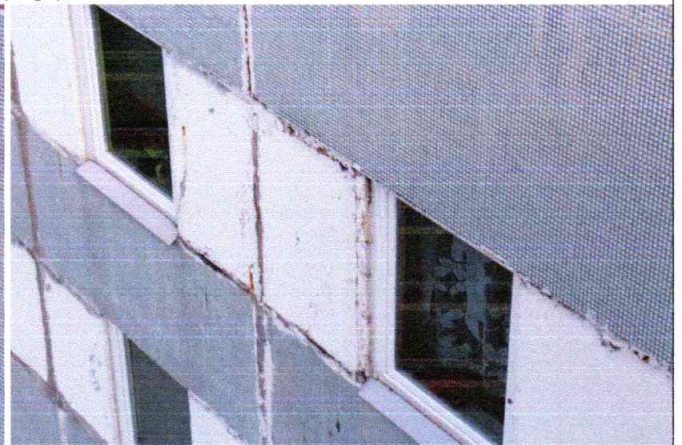
4.2.13. un 4.2.14. att. Mitruma bojājumi paneļu savienojuma vietās
