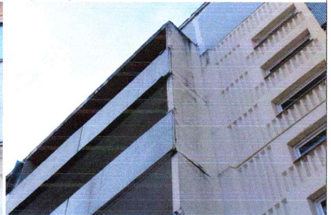
4.2.19. un 4.2.20. att. Mitrums uzkrājas ārēsienu konstrukcijās
